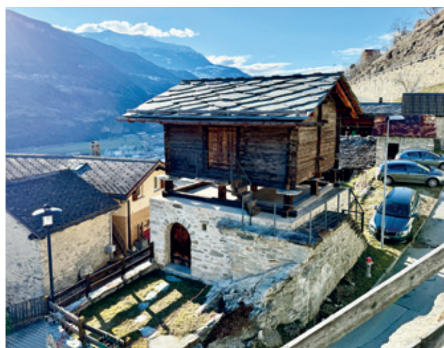
Weniger als 100 m von der Kirche entfernt liegt das Museum Trielstadel.
