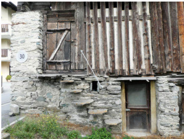
Westseite, Zugang Scheunengeschoss (© Castellani Architektur, Andreas Zimmerli, 09.2022)
