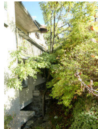
Südostseite mit Zwischenbau von Inv.-Nr. 132 (© Castellani Architektur, Andreas Zimmerli, 10.2022)
