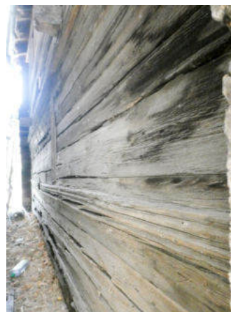
Nordostseite, Fassadenzieher (© Castellani Architektur, Andreas Zimmerli, 09.2022)
