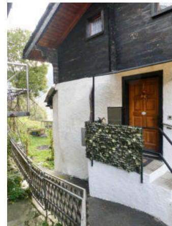
Nordseite, Zugang oberes Wohngeschoss (© Castellani Architektur, Andreas Zimmerli, 10.2022)
