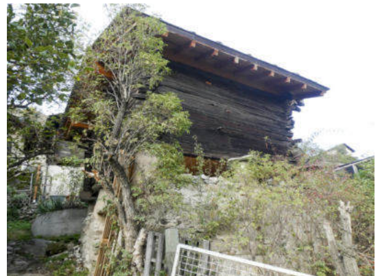
Südwestansicht (© Castellani Architektur, Andreas Zimmerli, 10.2022)
