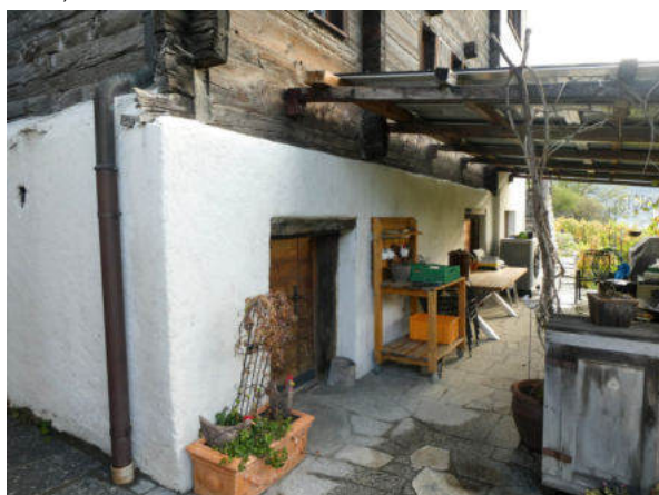
Südseite, Sockelgeschoss mit Kellerzugängen (© Castellani Architektur, Andreas Zimmerli, 10.2022)
