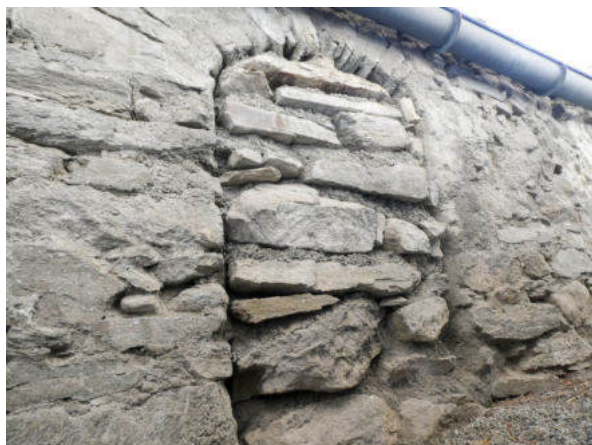
Ostseite, bauzeitlicher Zugang Saalgeschoss (© Castellani Architektur, Andreas Zimmerli, 10.2022)
