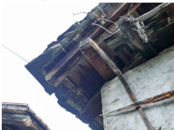
Südwestseite, Pfette steinerner Hausteil (© Castellani Architektur, Andreas Zimmerli, 10.2022)
