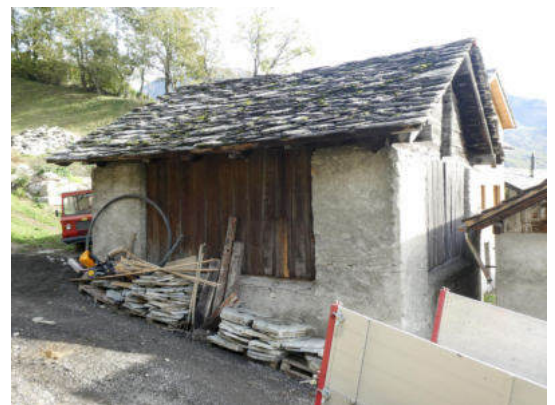
Nordwestansicht (© Castellani Architektur, Andreas Zimmerli, 10.2022)
