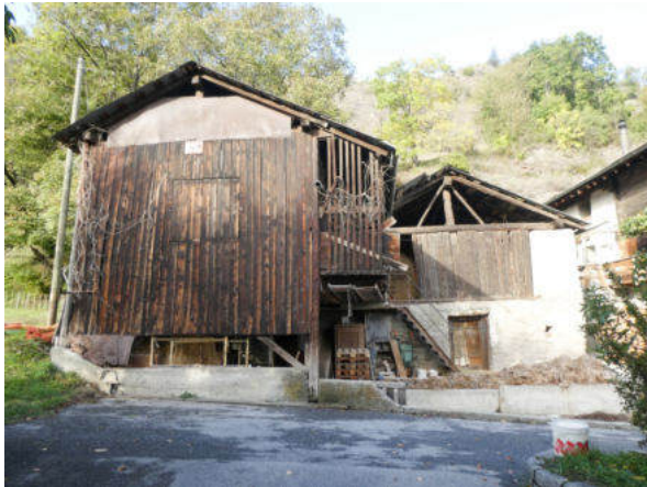
Südansicht Baugruppe (© Castellani Architektur, Andreas Zimmerli, 10.2022)
