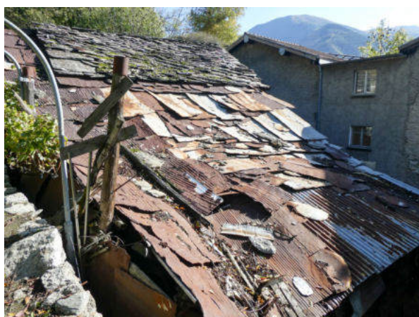
Nordwestansicht mit Anbau im Vordergrund (© Castellani Architektur, Andreas Zimmerli, 10.2022)
