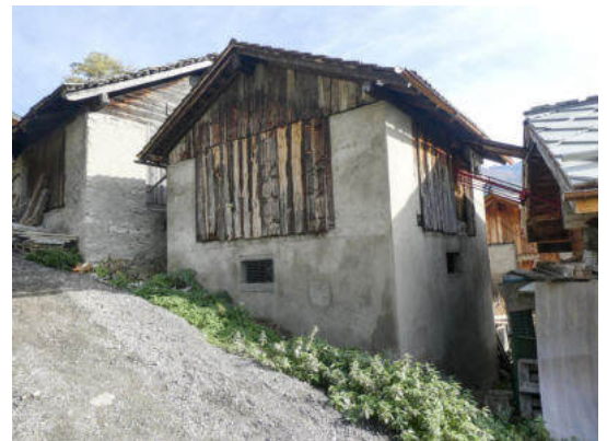
Nordwestansicht (© Castellani Architektur, Andreas Zimmerli, 10.2022)
