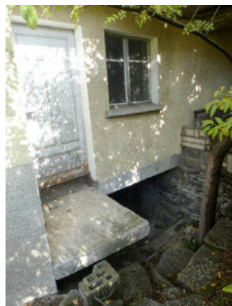
Südostseite, Zwischenbau, unteres Geschoss (© Castellani Architektur, Andreas Zimmerli, 10.2022)
