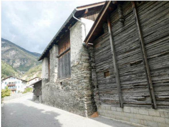
Nordwestansicht (© Castellani Architektur, Andreas Zimmerli, 09.2022)
