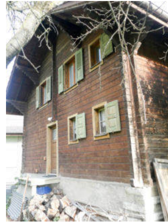
Nordwestseite, Zugang Wohngeschosse (© Castellani Architektur, Andreas Zimmerli, 10.2022)
