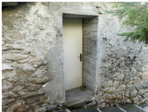
Nordseite, neuzeitlicher Zugang Saalgeschoss (© Castellani Architektur, Andreas Zimmerli, 10.2022)
