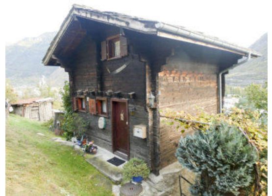
Nordwestansicht (© Castellani Architektur, Andreas Zimmerli, 10.2022)
