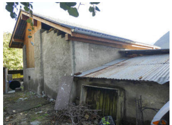
Nordwestansicht (© Castellani Architektur, Andreas Zimmerli, 10.2022)
