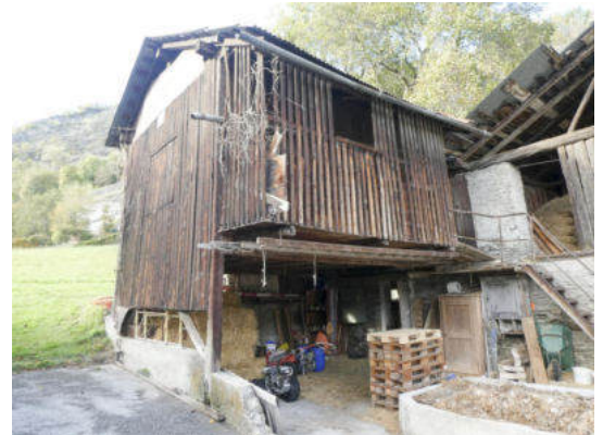
Südostansicht, Schopf (© Castellani Architektur, Andreas Zimmerli, 10.2022)
