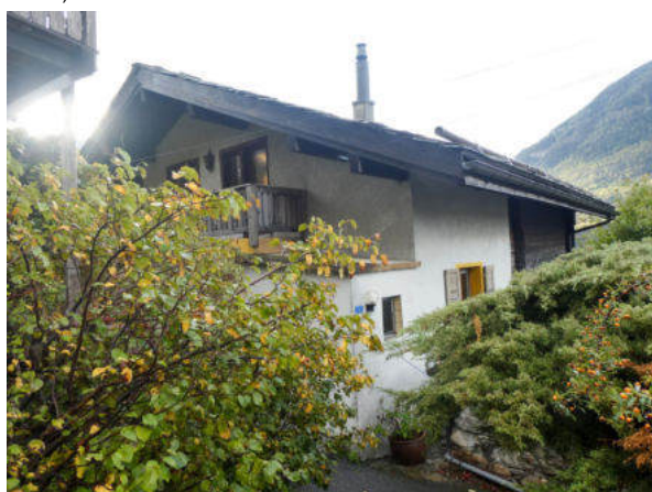
Nordwestansicht (© Castellani Architektur, Andreas Zimmerli, 10.2022)
