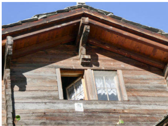
Südseite, Giebdreieck mit Fassadenschmuck (© Castellani Architektur, Andreas Zimmerli, 10.2022)
