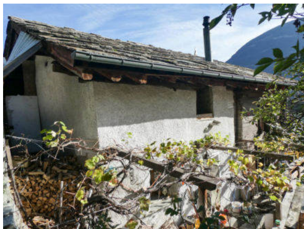
Nordwestansicht (© Castellani Architektur, Andreas Zimmerli, 10.2022)
