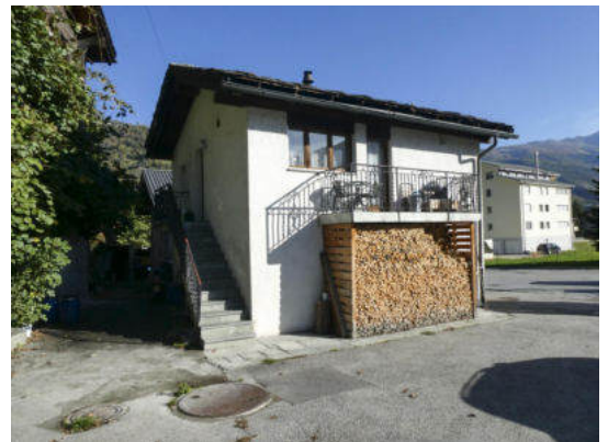
Nordwestansicht (© Castellani Architektur, Andreas Zimmerli, 10.2022)
