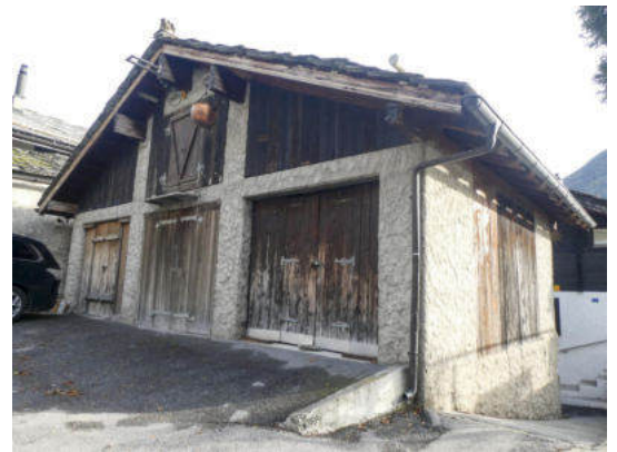
Nordwestansicht (© Castellani Architektur, Andreas Zimmerli, 10.2022)
