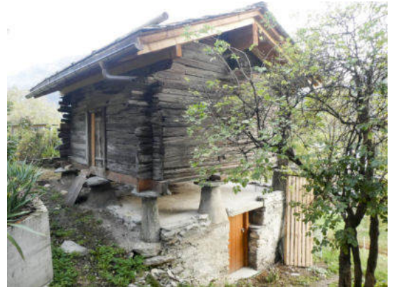
Nordwestansicht (© Castellani Architektur, Andreas Zimmerli, 10.2022)
