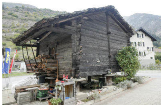
Südwestansicht (© Castellani Architektur, Andreas Zimmerli, 10.2022)
