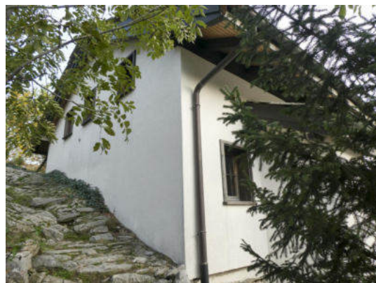
Nordwestansicht (© Castellani Architektur, Andreas Zimmerli, 10.2022)
