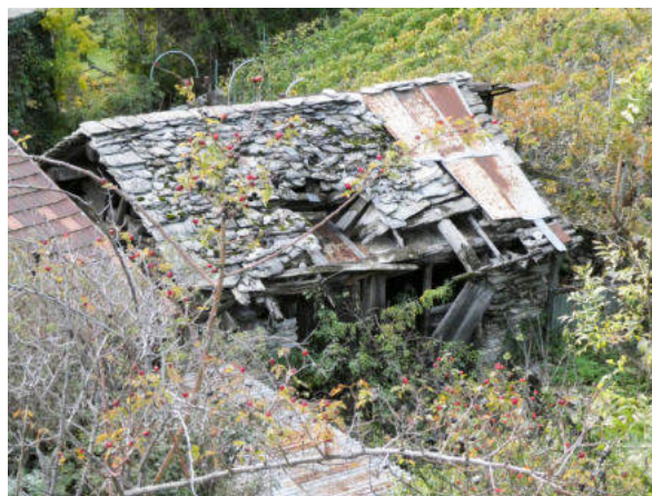
Südostansicht vom Weg nach dem Weiler Erb (© Castellani Architektur, Andreas Zimmerli, 10.2022)
