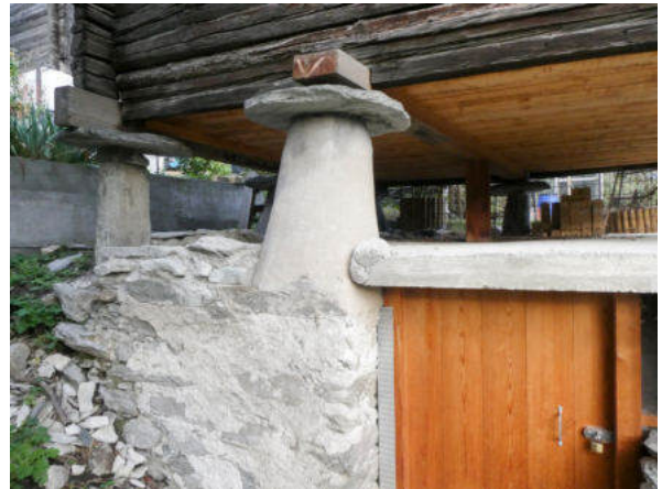
Westseite, steinerne Stützel (© Castellani Architektur, Andreas Zimmerli, 10.2022)
