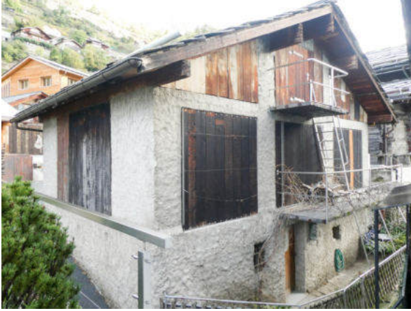
Südwestansicht (© Castellani Architektur, Andreas Zimmerli, 10.2022)
