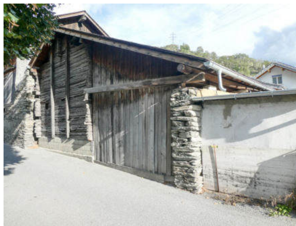
Nordwestansicht (© Castellani Architektur, Andreas Zimmerli, 09.2022)
