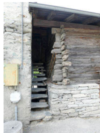
Nordostseite, Zugang Scheunengeschoss (© Castellani Architektur, Andreas Zimmerli, 09.2022)
