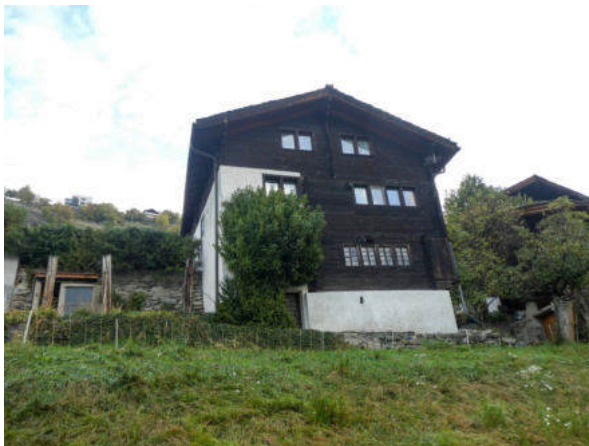
Südwestansicht (© Castellani Architektur, Andreas Zimmerli, 10.2022)
