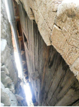
Nordostseite, Fensteröffnungen oberes Geschoss (© Castellani Architektur, Andreas Zimmerli, 09.2022)
