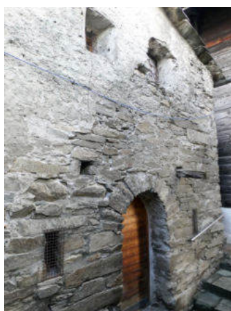
Südseite, Keller- und Saalgeschoss (© Castellani Architektur, Andreas Zimmerli, 10.2022)
