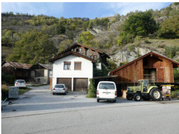
Südansicht Weiler Hof (© Castellani Architektur, Andreas Zimmerli, 10.2022)
