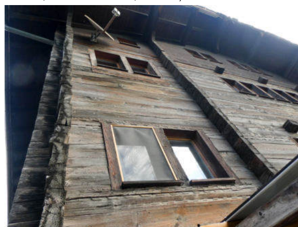
Südwestecke, Fassadenziegel Wohngeschoss (© Castellani Architektur, Andreas Zimmerli, 10.2022)
