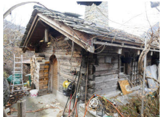
Nordwestansicht (© Castellani Architektur, Andreas Zimmerli, 12.2022)
