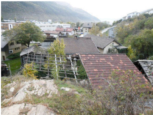
Südostansicht vom Weg nach dem Weiler Erb (© Castellani Architektur, Andreas Zimmerli, 10.2022)
