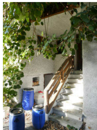
Südseite, Zugang Keller- und Saalgeschoss (© Castellani Architektur, Andreas Zimmerli, 10.2022)
