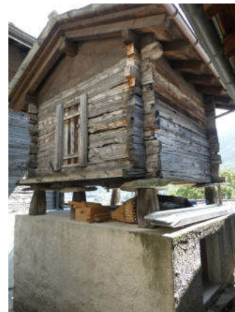
Nordwestansicht (© Castellani Architektur, Andreas Zimmerli, 08.2021)
