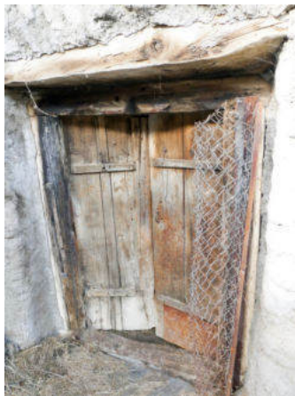
Südseite, Stalleingang (© Castellani Architektur, Andreas Zimmerli, 10.2022)
