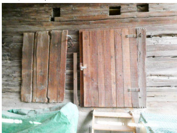
Südwestseite, Öffnungen unteres Geschoss (© Castellani Architektur, Andreas Zimmerli, 09.2022)
