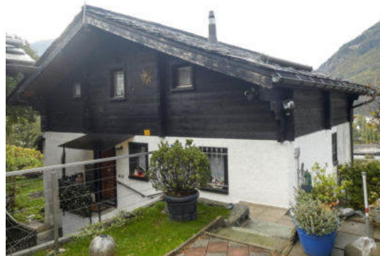
Nordwestansicht (© Castellani Architektur, Andreas Zimmerli, 10.2022)
