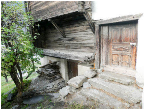
Ostseite, unteres Wohngeschoss (© Castellani Architektur, Andreas Zimmerli, 10.2022)
