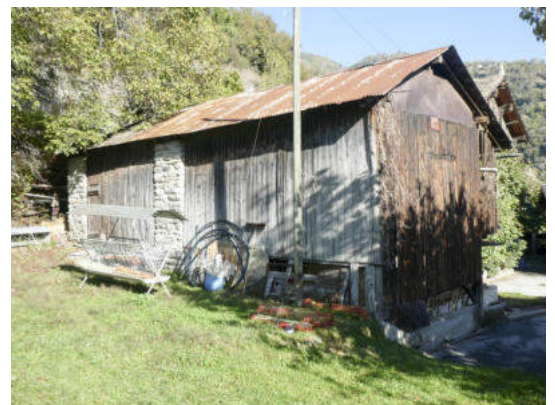
Südwestansicht, Stallscheune und Schopf (© Castellani Architektur, Andreas Zimmerli, 10.2022)
