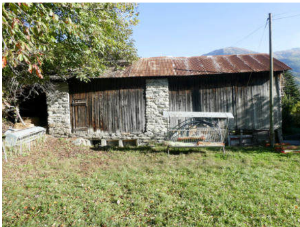
Westansicht, Stallscheune und Schopf (© Castellani Architektur, Andreas Zimmerli, 10.2022)
