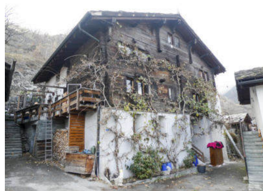
Südwestansicht (© Castellani Architektur, Andreas Zimmerli, 12.2022)
