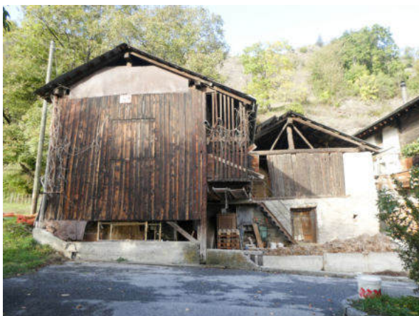
Südansicht Baugruppe (© Castellani Architektur, Andreas Zimmerli, 10.2022)
