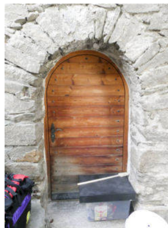
Südseite, Zugang Kellergeschoss (© Castellani Architektur, Andreas Zimmerli, 10.2022)
