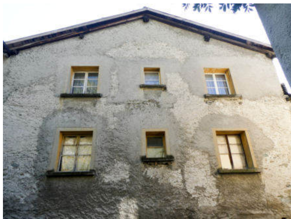
Nordansicht, Wohngeschosse (© Castellani Architektur, Andreas Zimmerli, 10.2022)
