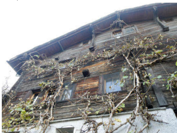
Südseite, Oberbau westliche Hausseite (© Castellani Architektur, Andreas Zimmerli, 12.2022)
