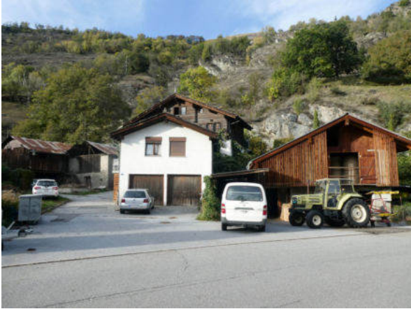
Südansicht Weiler Hof (© Castellani Architektur, Andreas Zimmerli, 10.2022)
