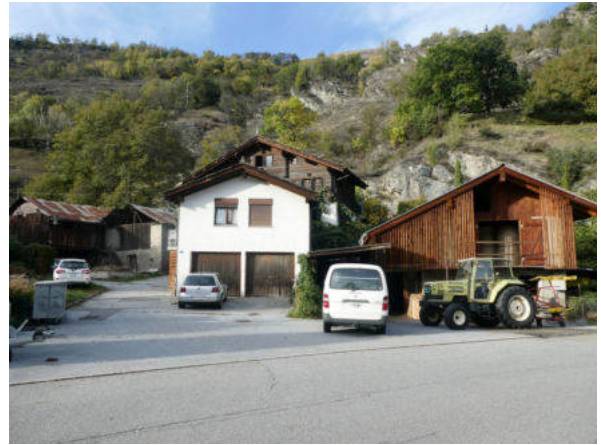
Südansicht Weiler Hof (© Castellani Architektur, Andreas Zimmerli, 10.2022)
