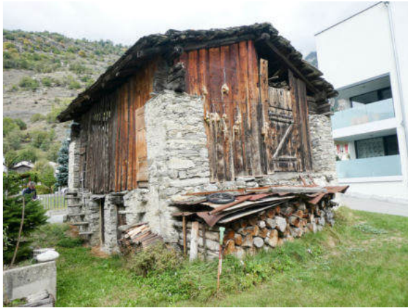
Südwestansicht (© Castellani Architektur, Andreas Zimmerli, 09.2022)
