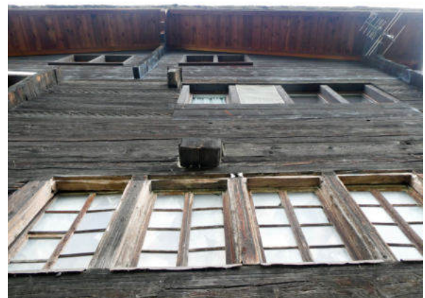
Südseite, Oberbau mit Fensteröffnungen (© Castellani Architektur, Andreas Zimmerli, 10.2022)
