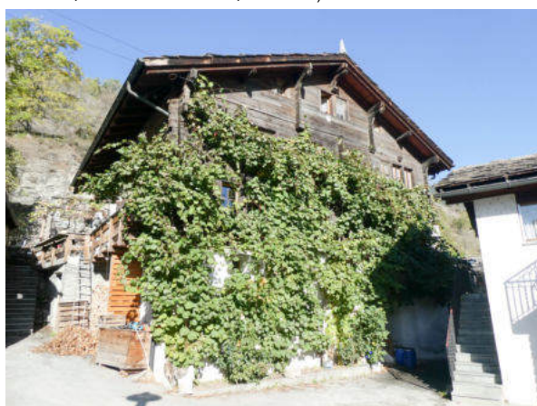
Südwestansicht (© Castellani Architektur, Andreas Zimmerli, 10.2022)
