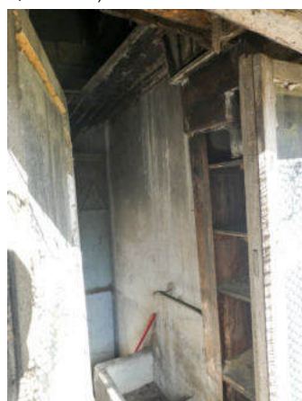
Südostseite, Trennwand zu Inv.-Nr. 132 (© Castellani Architektur, Andreas Zimmerli, 10.2022)
