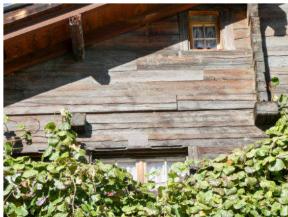
Südseite, Übergang zu Giebdreieck (© Castellani Architektur, Andreas Zimmerli, 10.2022)
