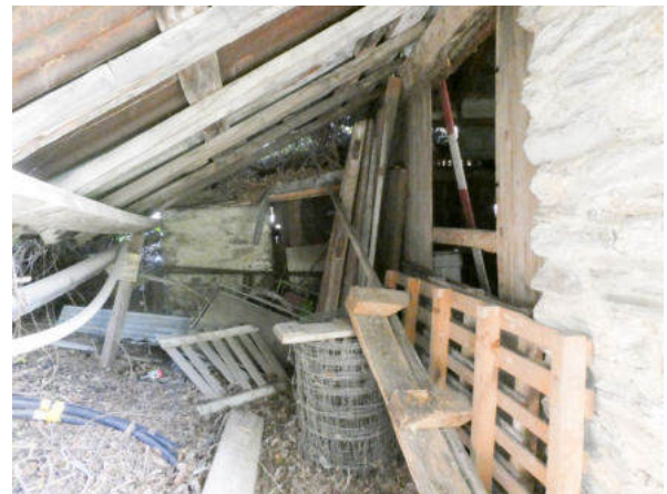
Nordseite, gedeckter Abstellplatz (© Castellani Architektur, Andreas Zimmerli, 10.2022)
