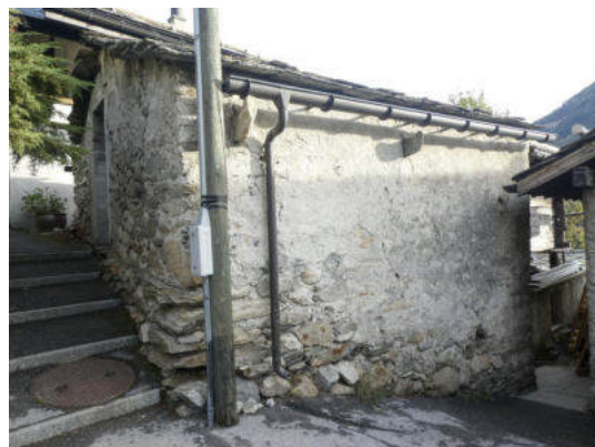
Nordwestansicht (© Castellani Architektur, Andreas Zimmerli, 10.2022)
