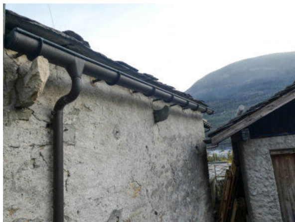
Westseite, Zwischenraum zu Inv.-Nr. 112 (© Castellani Architektur, Andreas Zimmerli, 10.2022)
