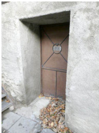
Westseite, Zugang Sockelgeschoss (© Castellani Architektur, Andreas Zimmerli, 10.2022)
