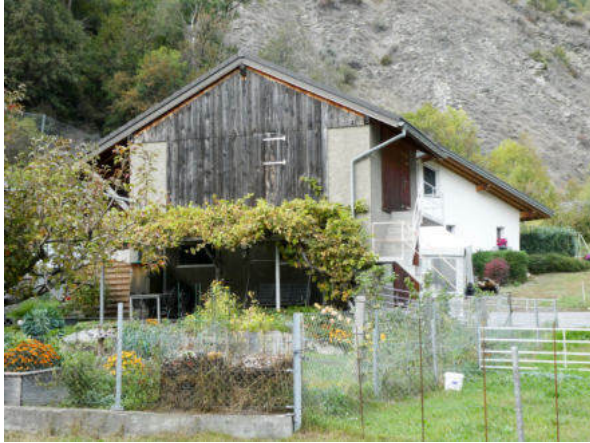
Südostansicht (© Castellani Architektur, Andreas Zimmerli, 10.2022)
