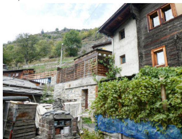
Südwestseite, Anbau (© Castellani Architektur, Andreas Zimmerli, 10.2022)
