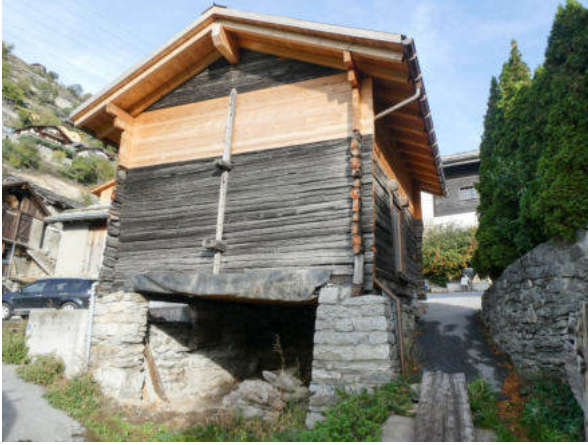
Südwestansicht (© Castellani Architektur, Andreas Zimmerli, 10.2022)
