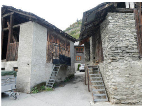
Südansicht Baugruppe (© Castellani Architektur, Andreas Zimmerli, 09.2022)
