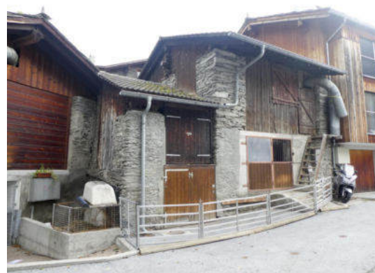
Südwestansicht (© Castellani Architektur, Andreas Zimmerli, 09.2022)
