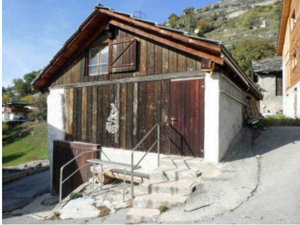
Südostansicht (© Castellani Architektur, Andreas Zimmerli, 10.2022)
