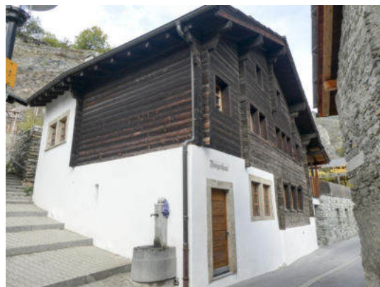
Südwestansicht © Castellani Architektur, Andreas Zimmerli, 10.2022
