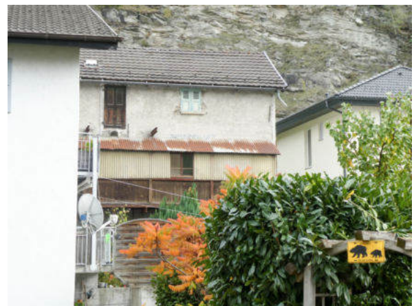
Nordwestseite mit Laube (© Castellani Architektur, Andreas Zimmerli, 10.2022)
