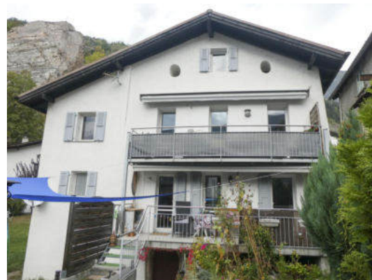
Südwestansicht (© Castellani Architektur, Andreas Zimmerli, 10.2022)
