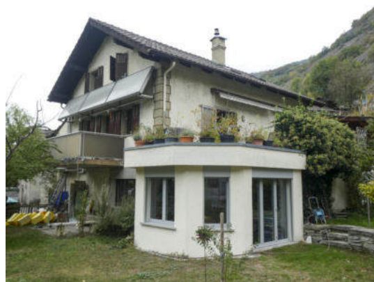
Südostansicht (© Castellani Architektur, Andreas Zimmerli, 10.2022)
