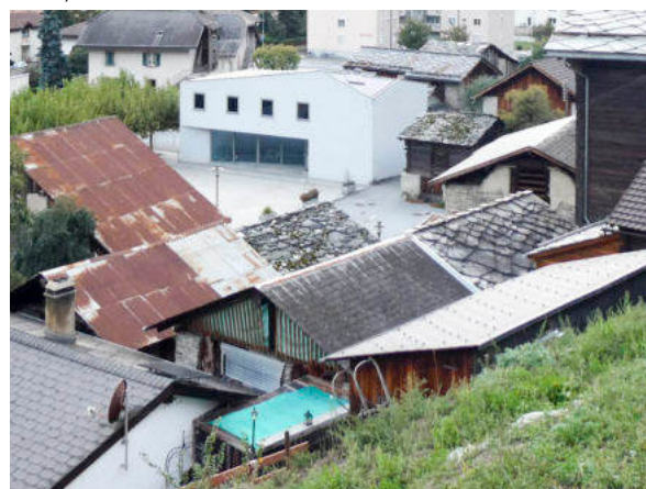
Nordostansicht Baugruppe (© Castellani Architektur, Andreas Zimmerli, 09.2022)
