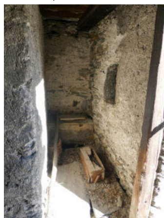
Gedeckter Zwischenbereich, Abort oberer Boden (© Castellani Architektur, Andreas Zimmerli, 10.2022)
