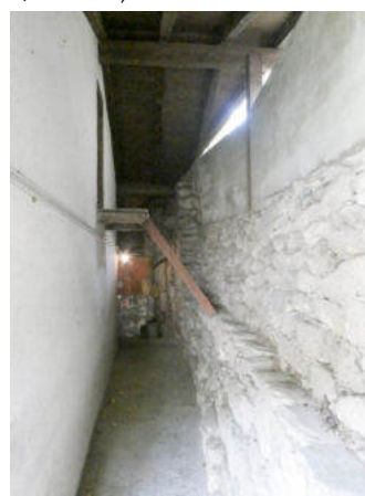
Nordseite, Zwischenbereich mit Stützmauer (© Castellani Architektur, Andreas Zimmerli, 10.2022)
