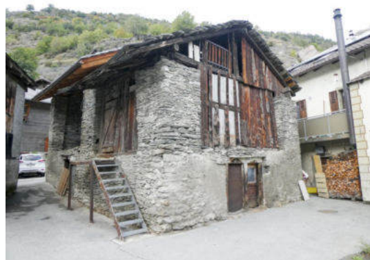
Südwestansicht © Castellani Architektur, Andreas Zimmerli, 09.2022
