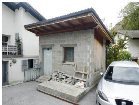
Südostansicht (© Castellani Architektur, Andreas Zimmerli, 10.2022)
