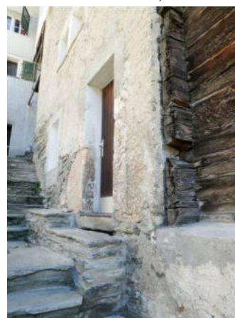
Westseite, Zugang unteres Wohngeschoss (© Castellani Architektur, Andreas Zimmerli, 10.2022)
