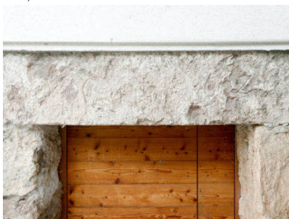
Ostseite, Türsturz Kellereingang (© Castellani Architektur, Andreas Zimmerli, 10.2022)
