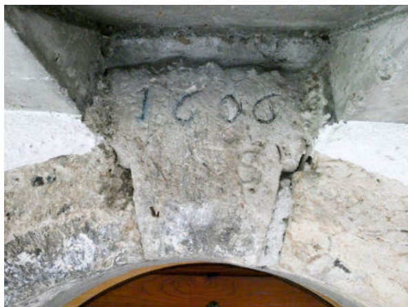
Südwestseite, Türsturz Kellereingang (© Castellani Architektur, Andreas Zimmerli, 10.2022)
