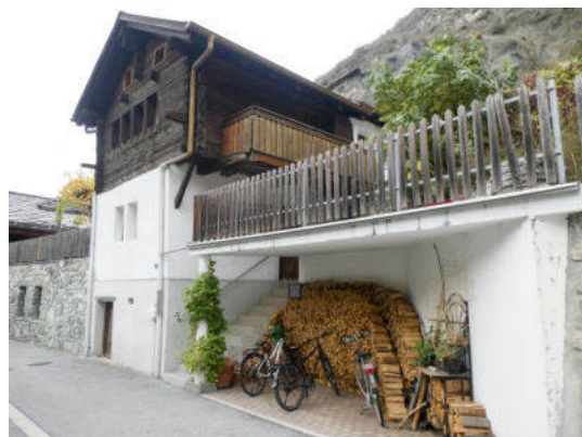
Südostansicht © Castellani Architektur, Andreas Zimmerli, 10.2022
