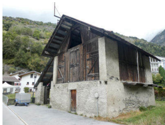
Südostansicht (© Castellani Architektur, Andreas Zimmerli, 09.2022)
