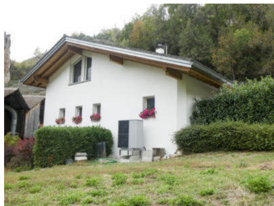
Südostansicht (© Castellani Architektur, Andreas Zimmerli, 10.2022)
