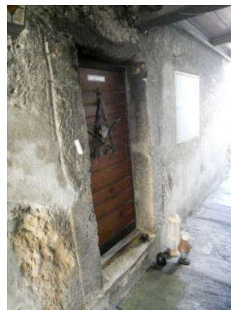
Nordseite, Zugang mittleres Wohngeschoss (© Castellani Architektur, Andreas Zimmerli, 10.2022)
