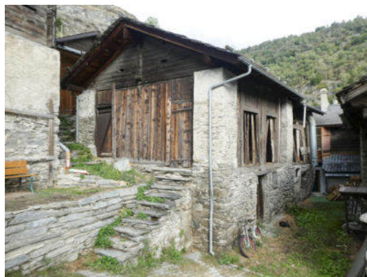
Südwestansicht (© Castellani Architektur, Andreas Zimmerli, 09.2022)
