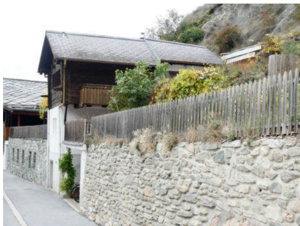
Mauer entlang des Sennereiweges von Osten (© Castellani Architektur, Andreas Zimmerli, 10.2022)
