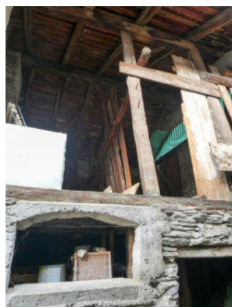
Südseite, nachträgliche Fensteröffnung (© Castellani Architektur, Andreas Zimmerli, 09.2022)
