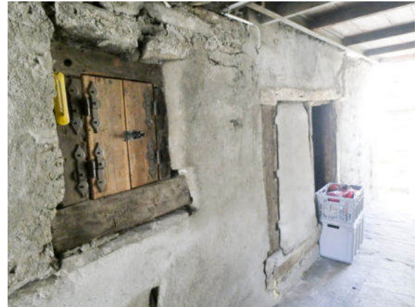
Gedeckter Zwischenbereich, Speicherteil (© Castellani Architektur, Andreas Zimmerli, 10.2022)
