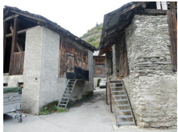
Südansicht Baugruppe (© Castellani Architektur, Andreas Zimmerli, 09.2022)
