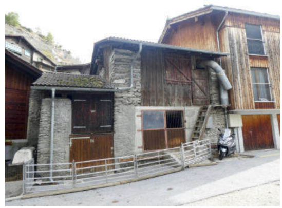
Südwestansicht (© Castellani Architektur, Andreas Zimmerli, 09.2022)
