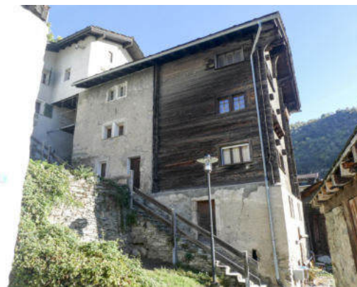
Südwestansicht (© Castellani Architektur, Andreas Zimmerli, 10.2022)
