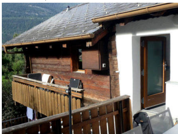
Ostseite, Übergang Vorder- zu Hinterhaus (© Castellani Architektur, Andreas Zimmerli, 07.2023)
