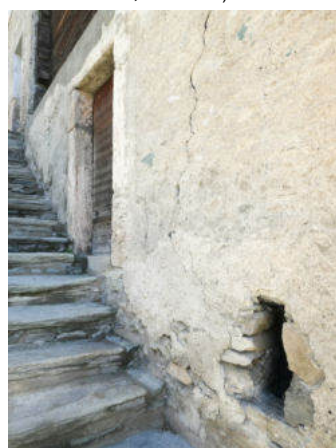
Westseite, Zugang Saalgeschoss (© Castellani Architektur, Andreas Zimmerli, 10.2022)
