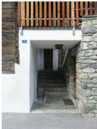
Südseite, Zugangsbereich (© Castellani Architektur, Andreas Zimmerli, 10.2022)
