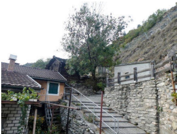
Südostansicht Baugruppe (© Castellani Architektur, Andreas Zimmerli, 09.2022)
