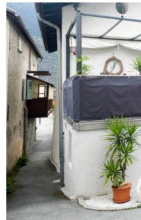
Nordwestseite, Zwischenraum zu Inv.-Nr. 82 (© Castellani Architektur, Andreas Zimmerli, 10.2022)
