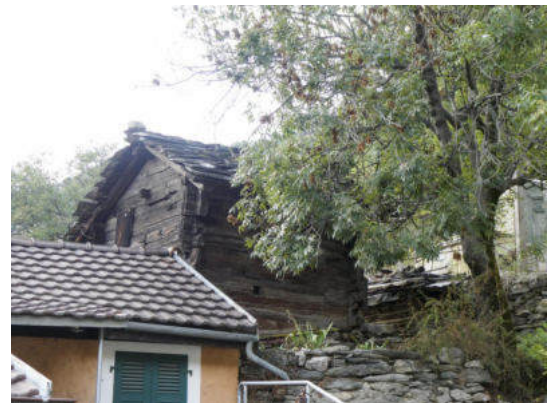
Südostansicht (© Castellani Architektur, Andreas Zimmerli, 09.2022)
