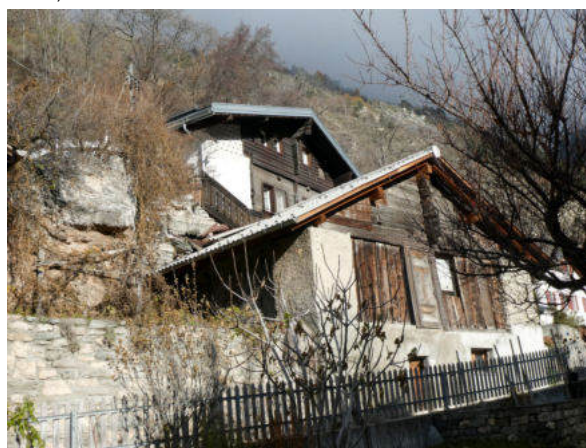
Südwestansicht (© Castellani Architektur, Andreas Zimmerli, 12.2022)
