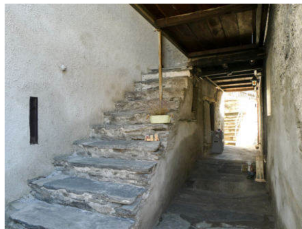
Gedeckter Zwischenbereich von Westen (© Castellani Architektur, Andreas Zimmerli, 10.2022)
