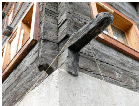
Südecke, ausgestalteter Fussbalken (© Castellani Architektur, Andreas Zimmerli, 10.2022)
