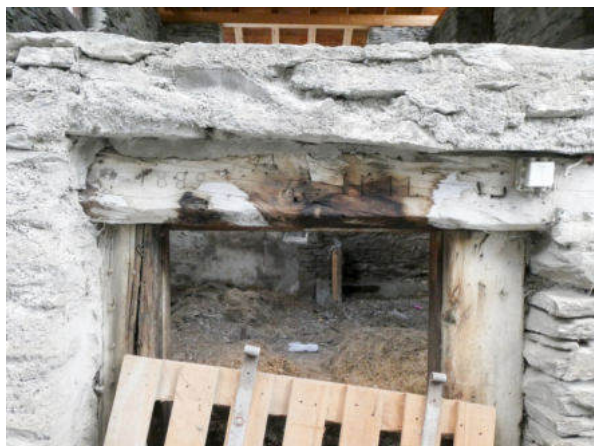
Südwestseite, Türsturz Stalleingang (© Castellani Architektur, Andreas Zimmerli, 09.2022)
