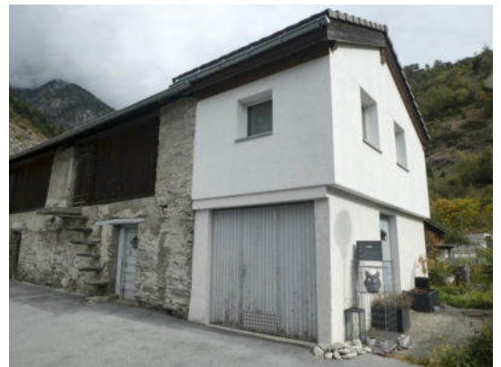
Südwestansicht (© Castellani Architektur, Andreas Zimmerli, 09.2022)
