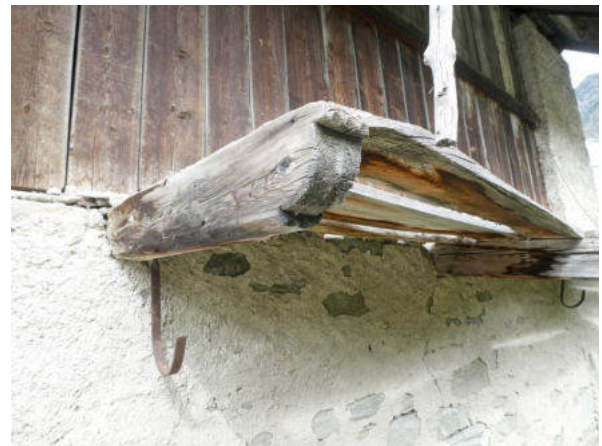
Südwestseite, Laube (© Castellani Architektur, Andreas Zimmerli, 09.2022)
