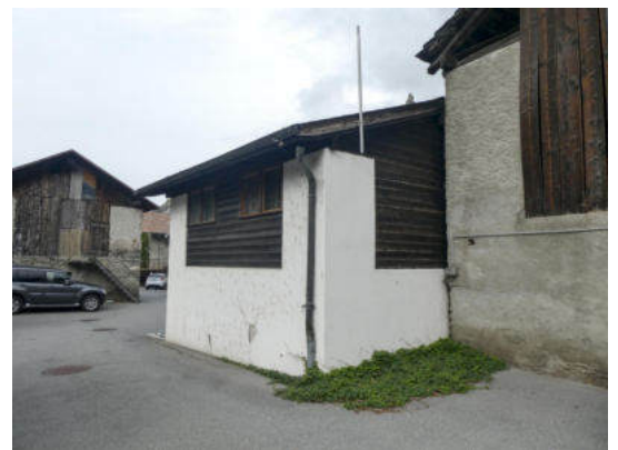
Südostansicht (© Castellani Architektur, Andreas Zimmerli, 09.2022)
