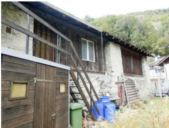
Südostansicht (© Castellani Architektur, Andreas Zimmerli, 09.2022)
