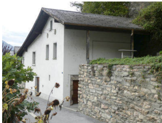
Südostansicht (© Castellani Architektur, Andreas Zimmerli, 10.2022)
