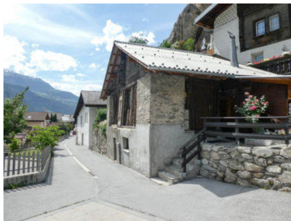
Südostansicht (© Castellani Architektur, Andreas Zimmerli, 05.2022)
