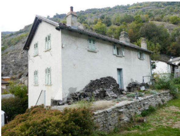
Südostansicht mit Hochwasserschutzdamm (© Castellani Architektur, Andreas Zimmerli, 10.2022)
