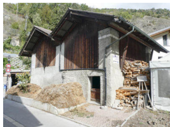
Südostansicht (© Castellani Architektur, Andreas Zimmerli, 09.2022)
