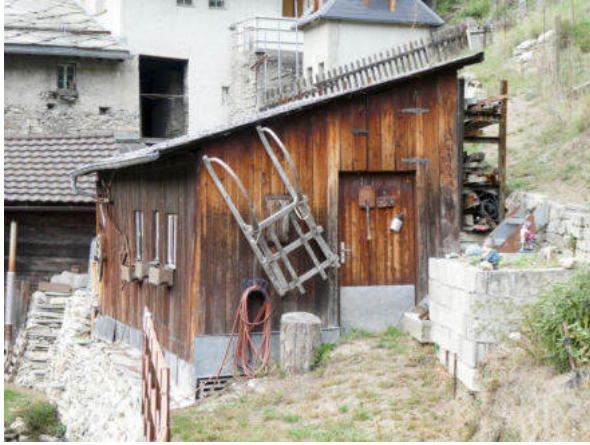
Südostansicht (© Castellani Architektur, Andreas Zimmerli, 09.2022)
