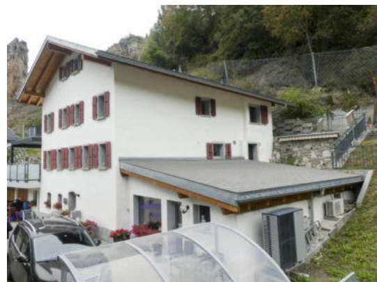
Südostansicht (© Castellani Architektur, Andreas Zimmerli, 10.2022)
