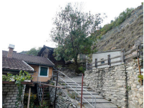
Südostansicht Baugruppe (© Castellani Architektur, Andreas Zimmerli, 09.2022)
