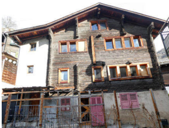
Südwestansicht (© Castellani Architektur, Andreas Zimmerli, 12.2022)
