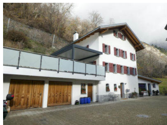
Südwestansicht (© Castellani Architektur, Andreas Zimmerli, 12.2022)
