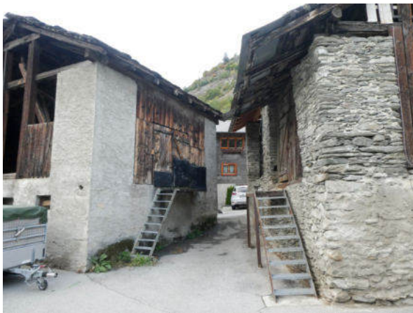
Südansicht Baugruppe (© Castellani Architektur, Andreas Zimmerli, 09.2022)
