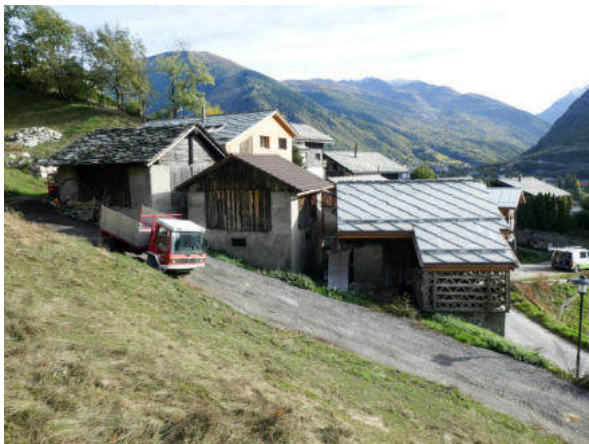
Nordwestansicht Baugruppe (© Castellani Architektur, Andreas Zimmerli, 10.2022)
