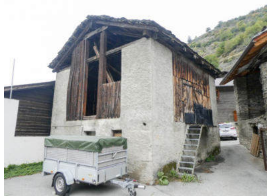
Südostansicht (© Castellani Architektur, Andreas Zimmerli, 09.2022)
