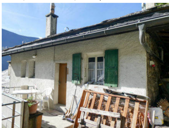
Ostseite, Zugang Wohngeschoss (© Castellani Architektur, Andreas Zimmerli, 10.2022)
