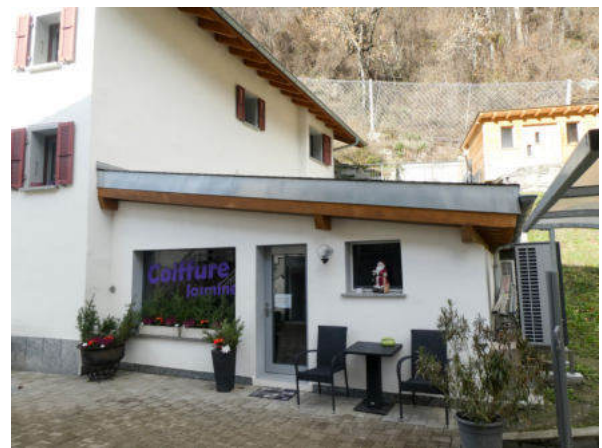
Südansicht ostseitiger Anbau (© Castellani Architektur, Andreas Zimmerli, 12.2022)
