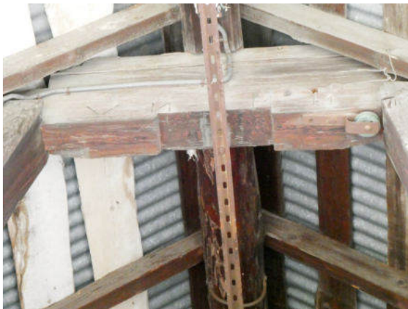
Südwestseite, Dachkonstruktion (© Castellani Architektur, Andreas Zimmerli, 09.2022)
