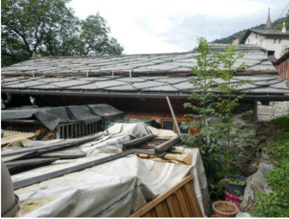
Südostansicht (© Castellani Architektur, Andreas Zimmerli, 09.2022)
