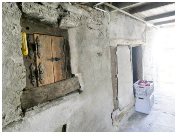
Gedeckter Zwischenbereich, Speicherteil (© Castellani Architektur, Andreas Zimmerli, 10.2022)
