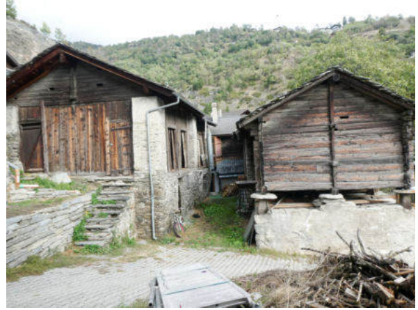
Westansicht Baugruppe (© Castellani Architektur, Andreas Zimmerli, 09.2022)
