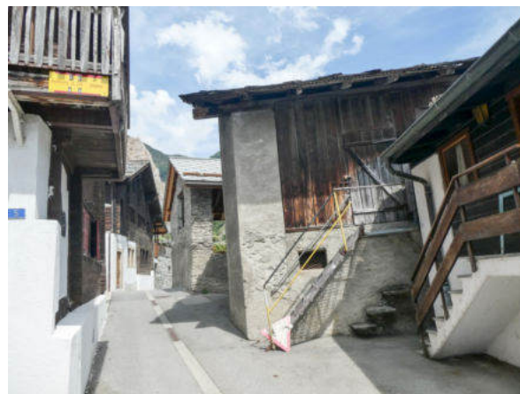
Westansicht Baugruppe (© Castellani Architektur, Andreas Zimmerli, 09.2022)
