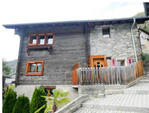
Südostansicht (© Castellani Architektur, Andreas Zimmerli, 10.2022)
