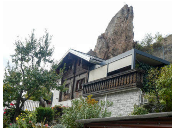
Südostansicht (© Castellani Architektur, Andreas Zimmerli, 10.2022)
