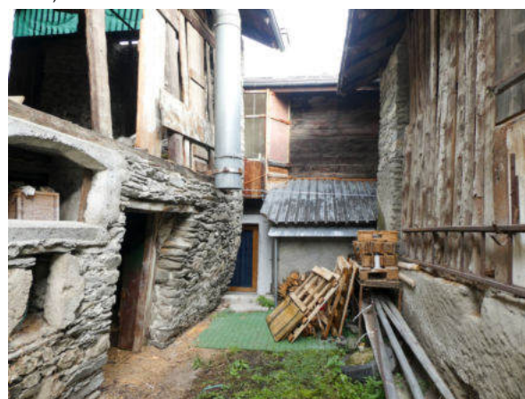
Südwestansicht (© Castellani Architektur, Andreas Zimmerli, 09.2022)
