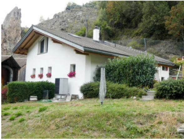
Südostansicht (© Castellani Architektur, Andreas Zimmerli, 10.2022)
