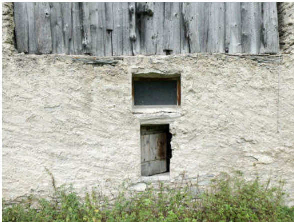
Nordostseite, Fassadenöffnungen (© Castellani Architektur, Andreas Zimmerli, 09.2022)
