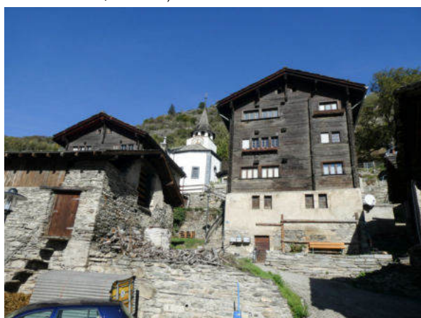
Südansicht Baugruppe (© Castellani Architektur, Andreas Zimmerli, 10.2022)
