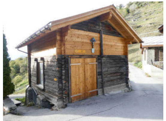
Südostansicht (© Castellani Architektur, Andreas Zimmerli, 10.2022)
