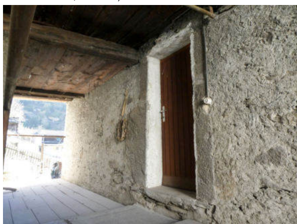
Nordseite, Zugang oberes Wohngeschoss (© Castellani Architektur, Andreas Zimmerli, 10.2022)
