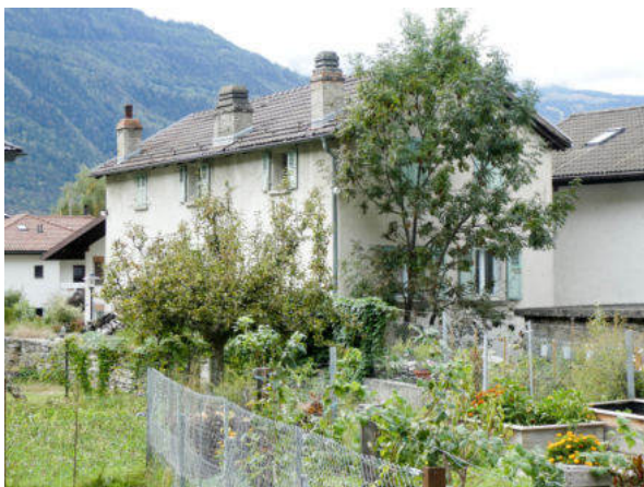
Südostansicht (© Castellani Architektur, Andreas Zimmerli, 10.2022)
