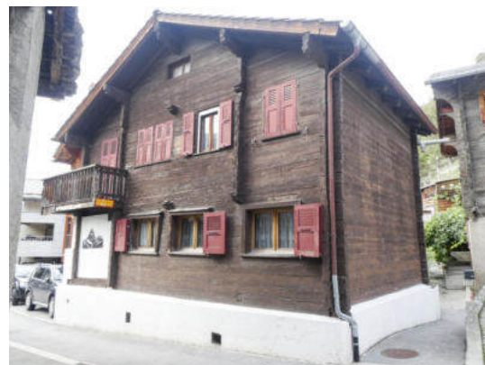
Südostansicht (© Castellani Architektur, Andreas Zimmerli, 10.2022)
