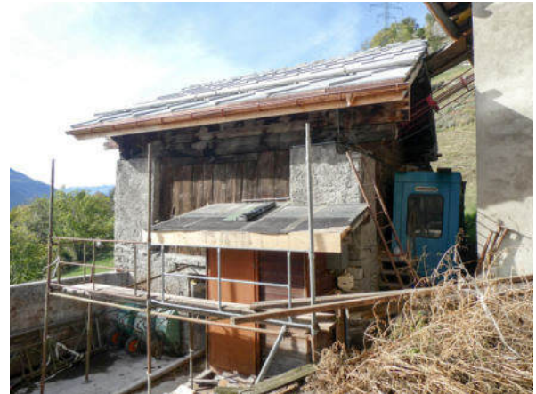
Südostansicht (© Castellani Architektur, Andreas Zimmerli, 10.2022)
