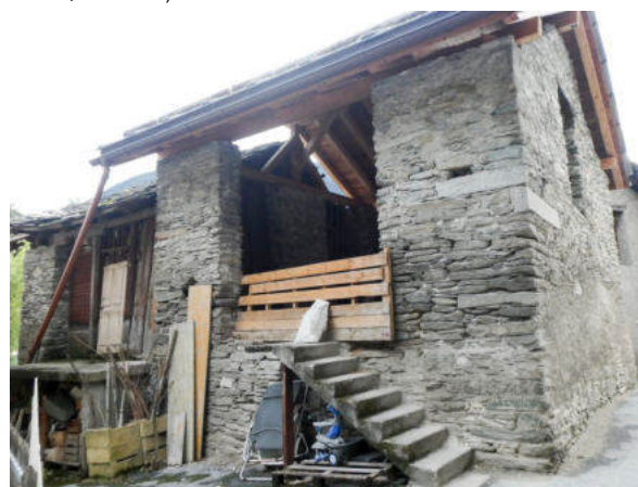
Nordostansicht Baugruppe (© Castellani Architektur, Andreas Zimmerli, 09.2022)
