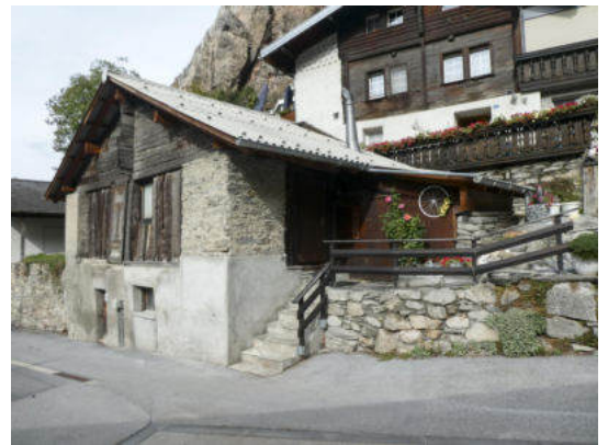
Südostansicht (© Castellani Architektur, Andreas Zimmerli, 09.2022)
