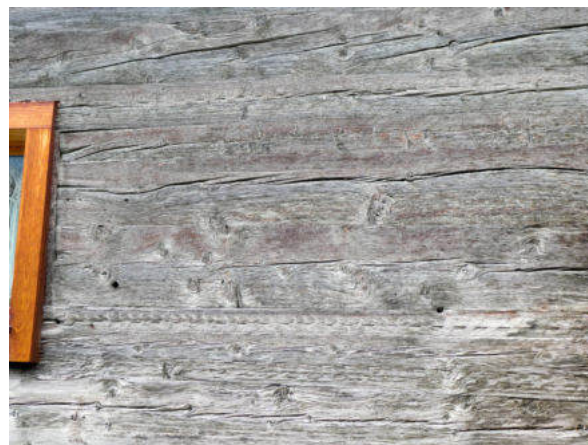
Südostseite, Zier mittleres Wohngeschoss (© Castellani Architektur, Andreas Zimmerli, 10.2022)
