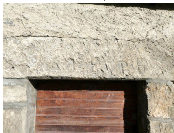
Südseite, Türsturz Kellergeschoss links (© Castellani Architektur, Andreas Zimmerli, 10.2022)
