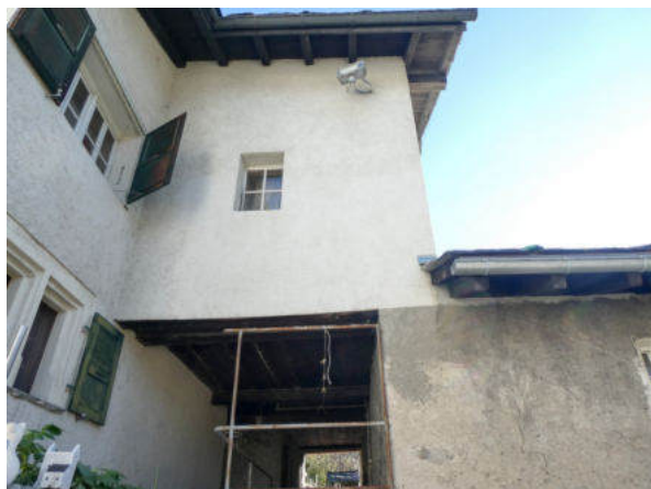
Westseite, Oberbau über Zwischenbereich (© Castellani Architektur, Andreas Zimmerli, 10.2022)
