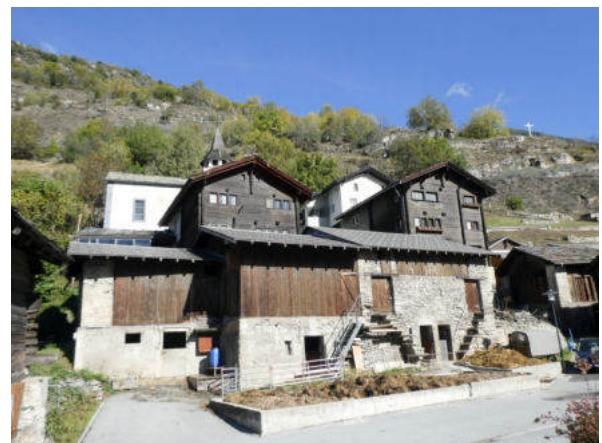
Südostansicht Baugruppe (© Castellani Architektur, Andreas Zimmerli, 10.2022)
