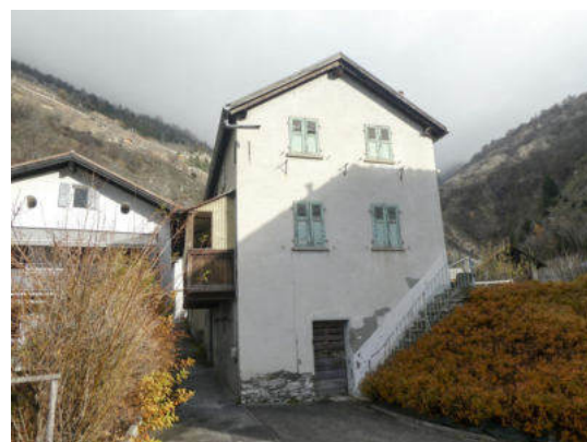
Südwestansicht (© Castellani Architektur, Andreas Zimmerli, 12.2022)
