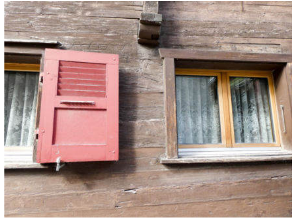
Südostseite, Fassadenzier unteres Wohngeschoss (© Castellani Architektur, Andreas Zimmerli, 10.2022)
