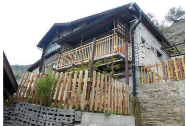
Südostansicht (© Castellani Architektur, Andreas Zimmerli, 10.2022)
