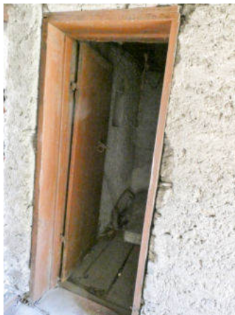
Gedeckter Zwischenbereich, Kammer oberer Boden (© Castellani Architektur, Andreas Zimmerli, 10.2022)
