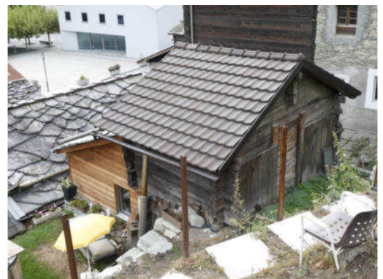
Südostansicht (© Castellani Architektur, Andreas Zimmerli, 09.2022)
