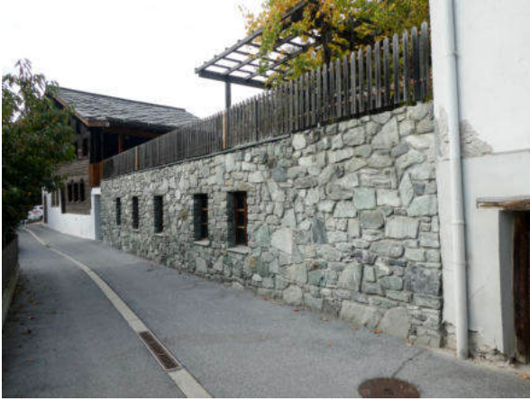
Südostansicht (© Castellani Architektur, Andreas Zimmerli, 10.2022)
