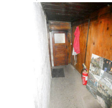
Westseite, Zugang Stube (links) und Küche (© Castellani Architektur, Andreas Zimmerli, 10.2022)
