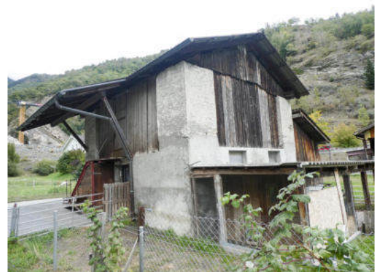
Südwestansicht (© Castellani Architektur, Andreas Zimmerli, 09.2022)
