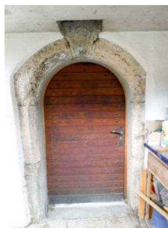
Südwestseite, Türsturz Kellereingang (© Castellani Architektur, Andreas Zimmerli, 10.2022)
