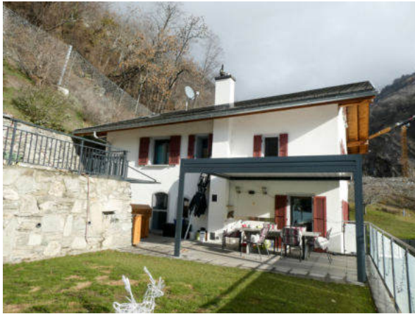
Westansicht Kernbau (© Castellani Architektur, Andreas Zimmerli, 12.2022)
