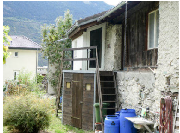
Nordostansicht, Übergang zu Inv.-Nr. 78 (© Castellani Architektur, Andreas Zimmerli, 09.2022)
