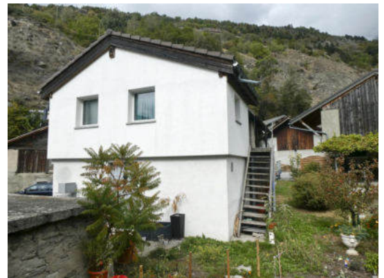
Südostansicht (© Castellani Architektur, Andreas Zimmerli, 09.2022)
