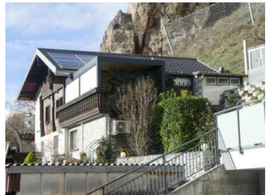
Südostansicht (© Castellani Architektur, Andreas Zimmerli, 12.2022)
