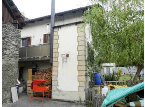
Westseite mit Abort-Anbau (© Castellani Architektur, Andreas Zimmerli, 10.2022)
