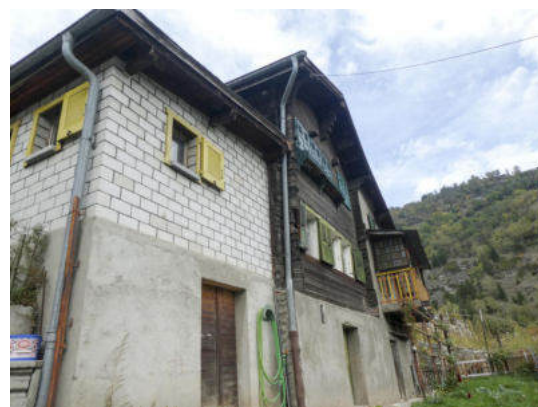
Südwestansicht (© Castellani Architektur, Andreas Zimmerli, 10.2022)
