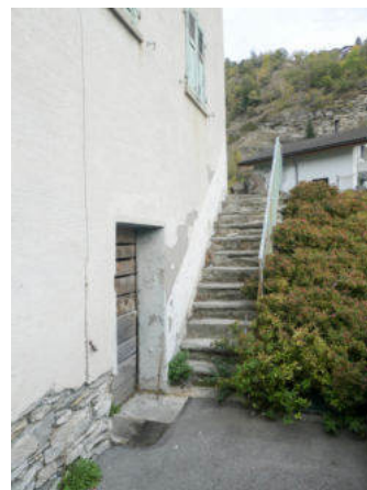
Südwestseite, Sockelgeschoss und Aussentreppe (© Castellani Architektur, Andreas Zimmerli, 10.2022)
