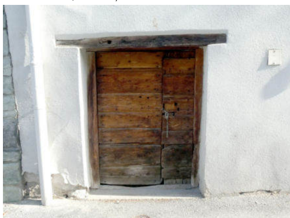
Südseite, Kellereingang (© Castellani Architektur, Andreas Zimmerli, 07.2023)
