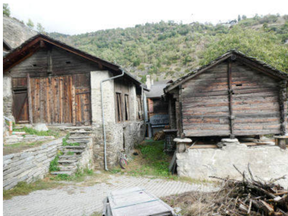
Westansicht Baugruppe (© Castellani Architektur, Andreas Zimmerli, 09.2022)
