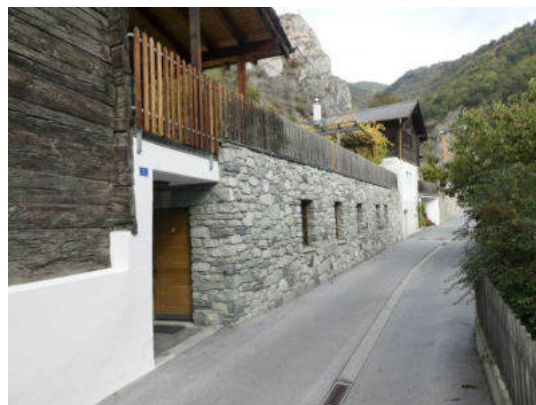
Südwestansicht (© Castellani Architektur, Andreas Zimmerli, 10.2022)
