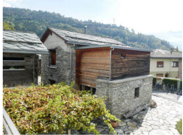
Nordwestansicht (© Castellani Architektur, Andreas Zimmerli, 10.2022)
