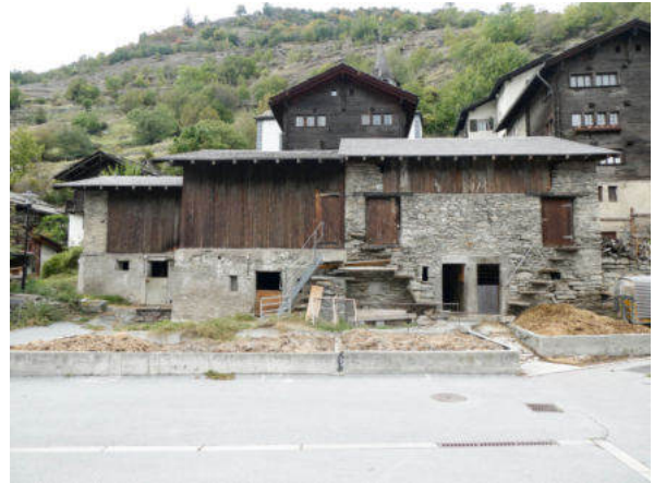
Südansicht Baugruppe (© Castellani Architektur, Andreas Zimmerli, 09.2022)
