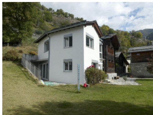
Südwestansicht (© Castellani Architektur, Andreas Zimmerli, 10.2022)
