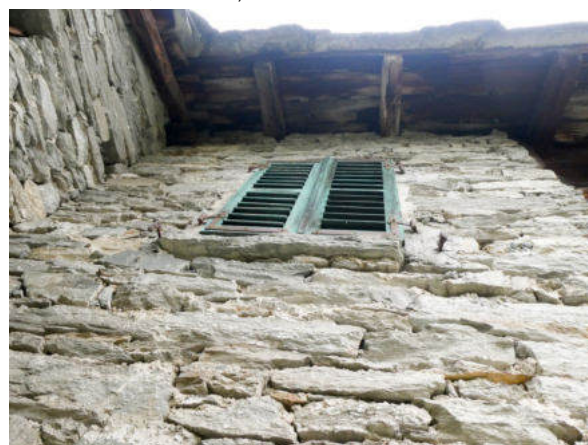
Westseite, Hinterhaus mit Fensteröffnung (© Castellani Architektur, Andreas Zimmerli, 10.2022)
