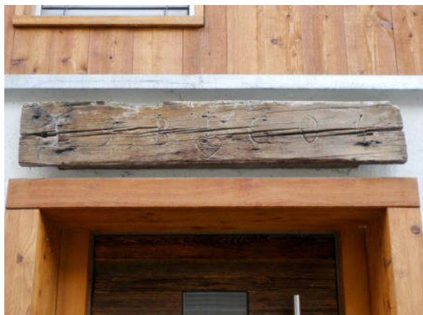
Nordseite, Brett mit Datierungsangabe (© Castellani Architektur, Andreas Zimmerli, 10.2022)
