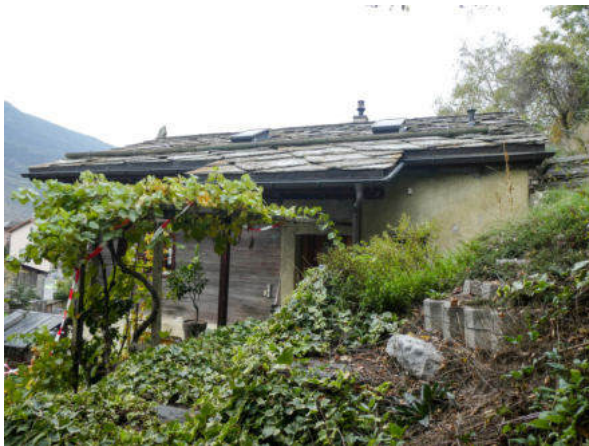
Ostansicht mit Freiraum und Laube (© Castellani Architektur, Andreas Zimmerli, 10.2022)
