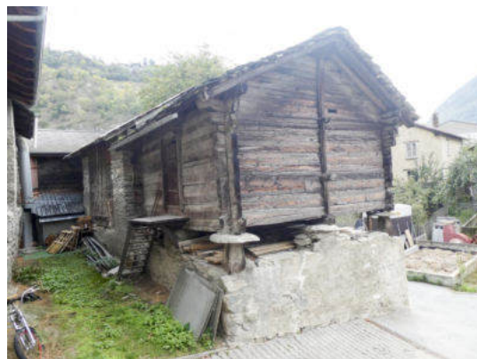
Nordwestansicht (© Castellani Architektur, Andreas Zimmerli, 10.2022)
