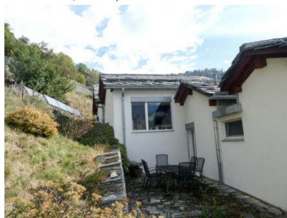
Nordwestansicht, Übergang zu Inv.-Nr. 15 (© Castellani Architektur, Andreas Zimmerli, 10.2022)
