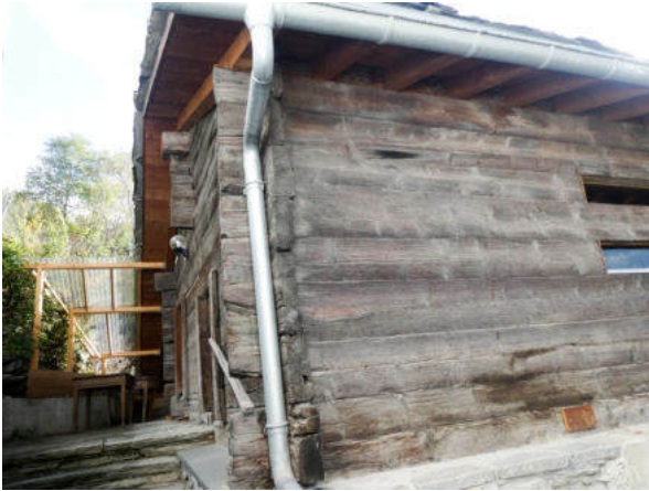
Nordwestansicht (© Castellani Architektur, Andreas Zimmerli, 10.2022)
