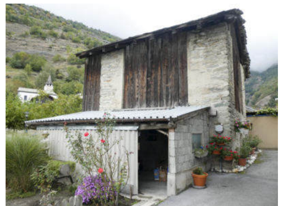
Südwestansicht (© Castellani Architektur, Andreas Zimmerli, 09.2022)
