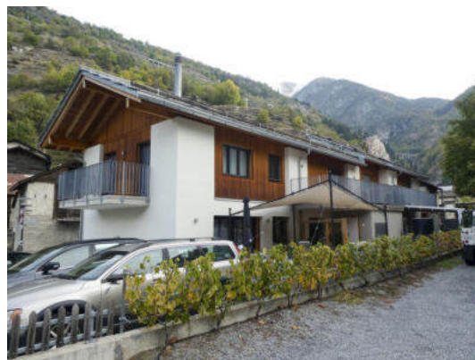
Südwestansicht (© Castellani Architektur, Andreas Zimmerli, 10.2022)
