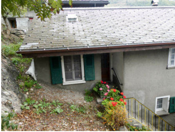
Westseite, Hinterhaus-Verlängerung (© Castellani Architektur, Andreas Zimmerli, 10.2022)
