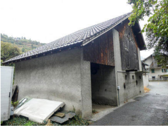
Nordwestansicht (© Castellani Architektur, Andreas Zimmerli, 09.2022)
