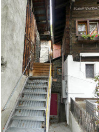
Westseite, Zwischenraum zu Inv.-Nr. 42 (© Castellani Architektur, Andreas Zimmerli, 10.2022)
