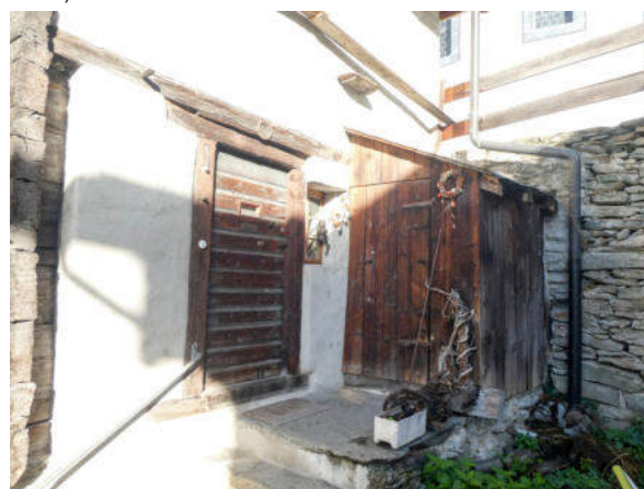
Ostseite, Zugang und Abort-Anbau (© Castellani Architektur, Andreas Zimmerli, 10.2022)
