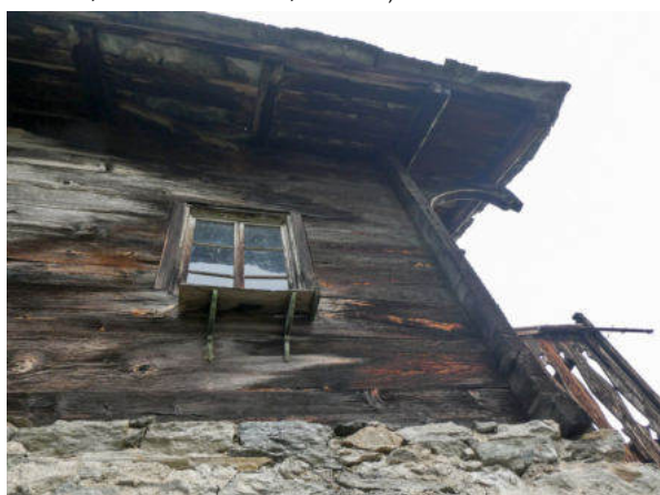
Südwestecke, Oberbau mit Fensteröffnung (© Castellani Architektur, Andreas Zimmerli, 10.2022)
