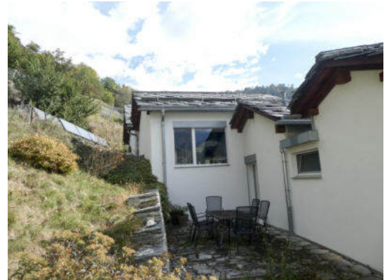
Nordwestansicht, Übergang zu Inv.-Nr. 16 (© Castellani Architektur, Andreas Zimmerli, 10.2022)
