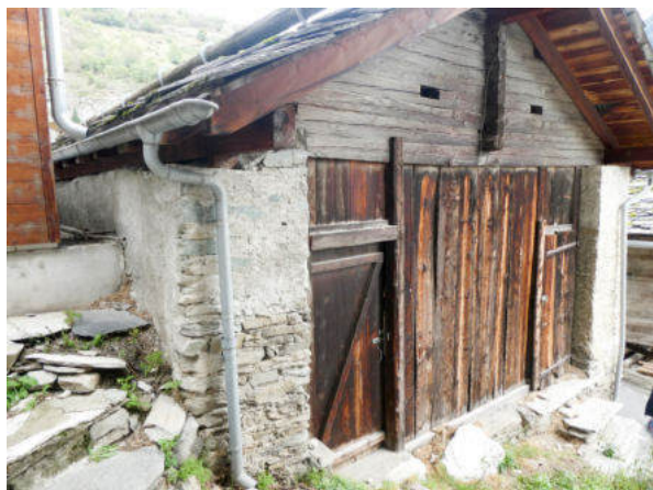
Nordwestansicht (© Castellani Architektur, Andreas Zimmerli, 09.2022)
