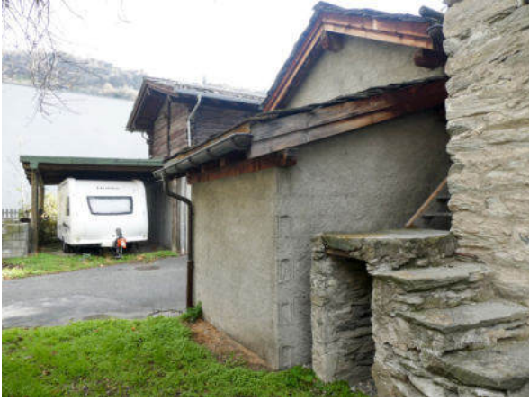
Nordwestansicht (© Castellani Architektur, Andreas Zimmerli, 12.2022)
