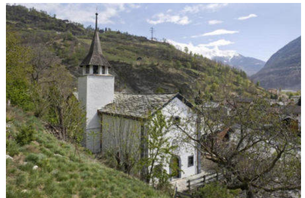
Ansicht von Nordwesten (© DIB, KGS, Thomas Andenmatten, 2012).
