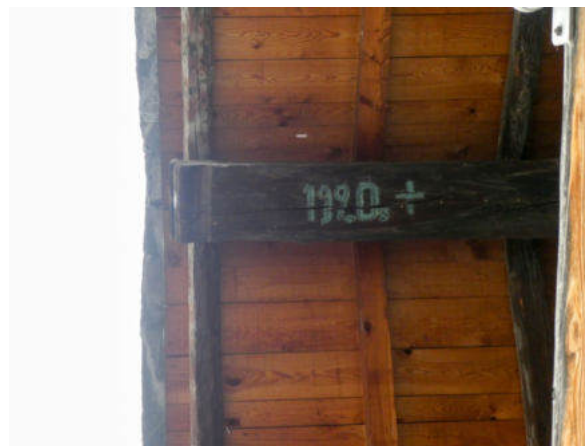
Südseite, Firstpfette (© Castellani Architektur, Andreas Zimmerli, 09.2022)
