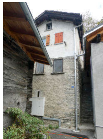
Südwestansicht (© Castellani Architektur, Andreas Zimmerli, 10.2022)
