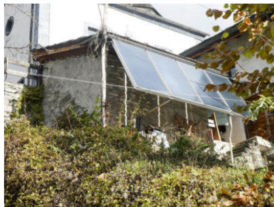
Südwestansicht (© Castellani Architektur, Andreas Zimmerli, 12.2022)
