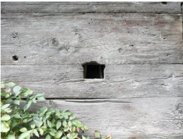
Ostseite, kleine Belüftungsöffnung (© Castellani Architektur, Andreas Zimmerli, 09.2022)
