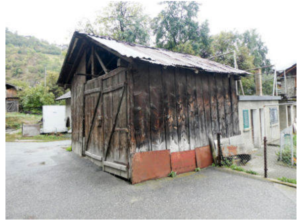
Nordwestansicht (© Castellani Architektur, Andreas Zimmerli, 09.2022)
