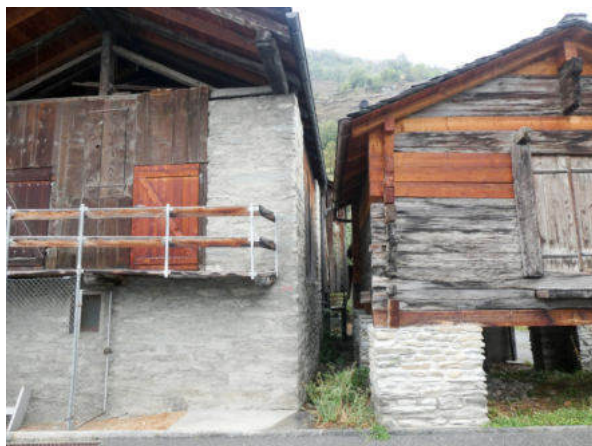
Südseite, Zwischenraum zu Inv.-Nr. 28 (© Castellani Architektur, Andreas Zimmerli, 09.2022)
