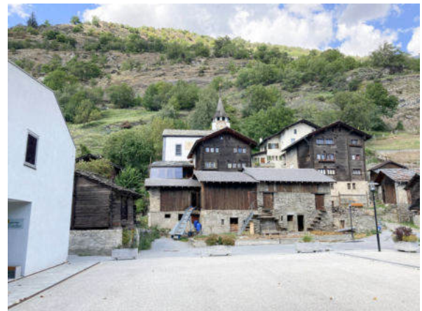
Südansicht Baugruppe (© Castellani Architektur, Andreas Zimmerli, 08.2022)
