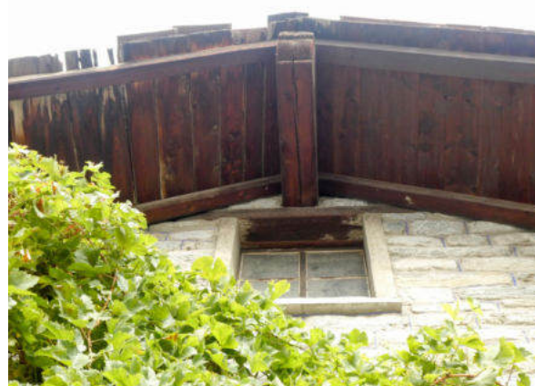
Südseite, Giebelndreieck (© Castellani Architektur, Andreas Zimmerli, 10.2022)
