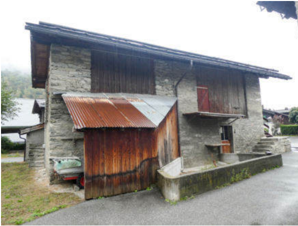
Nordwestansicht (© Castellani Architektur, Andreas Zimmerli, 09.2022)
