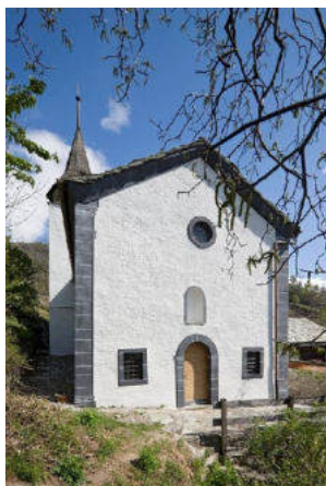
Ansicht von Westen (© DIB, KGS, Thomas Andenmatten, 2012).
