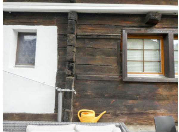
Südseite, Fassadenziegel unteres Wohngeschoss (© Castellani Architektur, Andreas Zimmerli, 10.2022)
