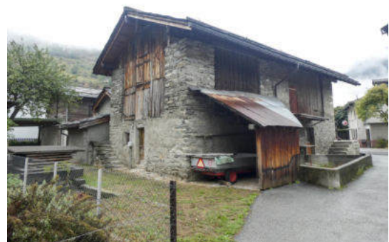
Nordwestansicht (© Castellani Architektur, Andreas Zimmerli, 09.2022)
