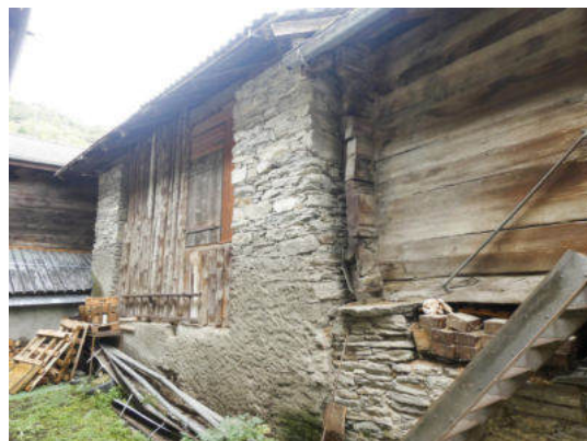
Nordwestansicht (© Castellani Architektur, Andreas Zimmerli, 09.2022)
