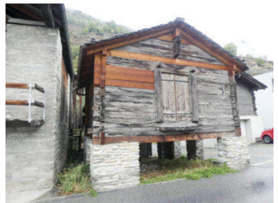
Südwestansicht (© Castellani Architektur, Andreas Zimmerli, 09.2022)
