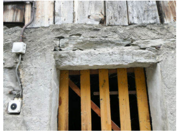
Nordseite, Türsturz Stalleingang (© Castellani Architektur, Andreas Zimmerli, 09.2022)
