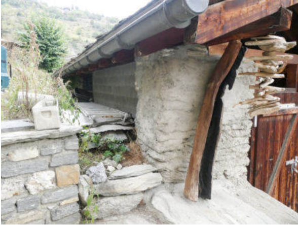
Nordwestansicht (© Castellani Architektur, Andreas Zimmerli, 10.2022)
