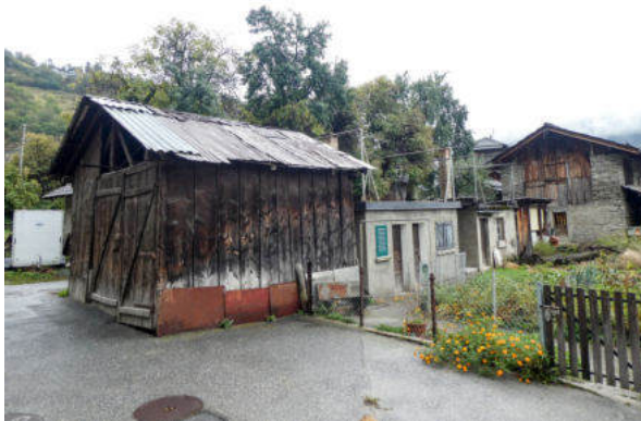
Nordwestansicht Baugruppe und Nutzgärten (© Castellani Architektur, Andreas Zimmerli, 09.2022)
