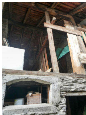
Südseite, nachträgliche Fensteröffnung (© Castellani Architektur, Andreas Zimmerli, 09.2022)
