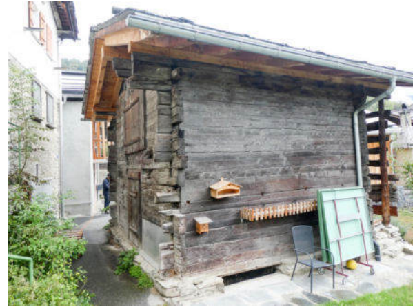
Nordwestansicht (© Castellani Architektur, Andreas Zimmerli, 09.2022)
