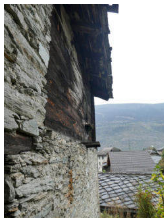
Westseite, Übergang Hinter- zu Vorderhaus (© Castellani Architektur, Andreas Zimmerli, 10.2022)
