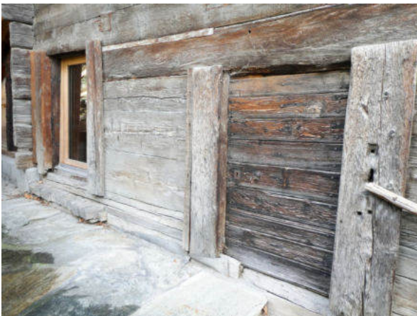
Nordseite, Zugänge Stadel- und Speicherteil (© Castellani Architektur, Andreas Zimmerli, 10.2022)
