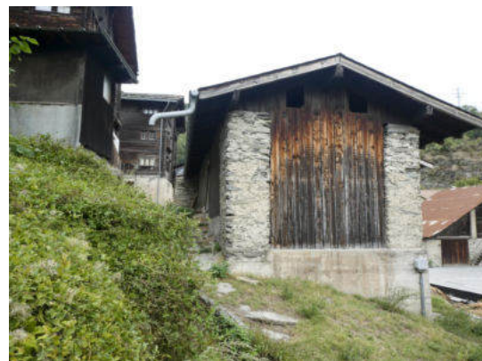
Nordwestansicht (© Castellani Architektur, Andreas Zimmerli, 09.2022)
