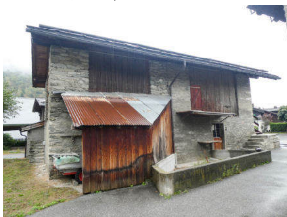
Nordwestansicht (© Castellani Architektur, Andreas Zimmerli, 09.2022)
