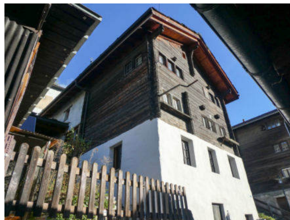
Südwestansicht (© Castellani Architektur, Andreas Zimmerli, 10.2022)
