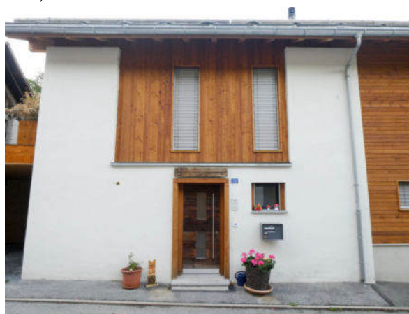
Nordseite, einstige Stallscheune (© Castellani Architektur, Andreas Zimmerli, 10.2022)
