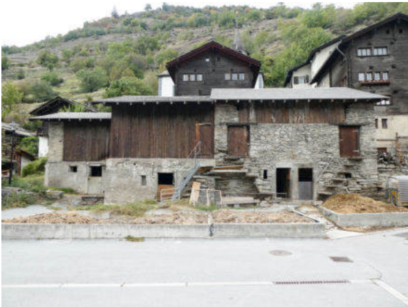
Südansicht Baugruppe (© Castellani Architektur, Andreas Zimmerli, 09.2022)
