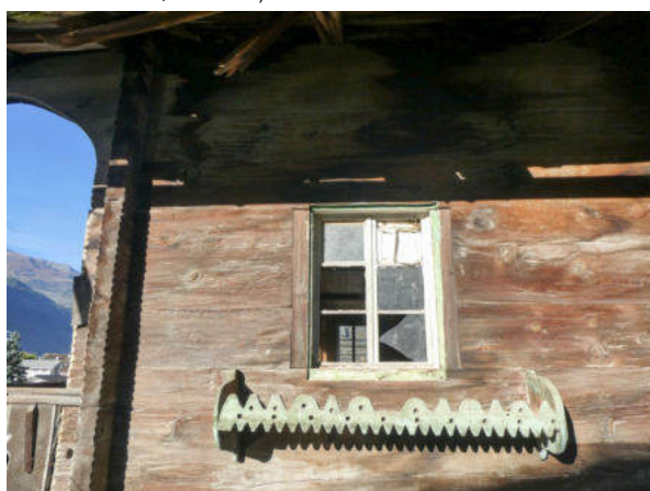
Südostecke, Oberbau mit Fensteröffnung (© Castellani Architektur, Andreas Zimmerli, 10.2022)
