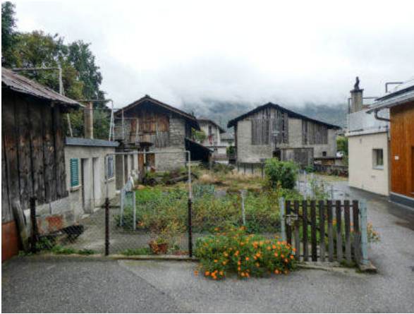
Nordansicht Baugruppe und Nutzgärten (© Castellani Architektur, Andreas Zimmerli, 09.2022)
