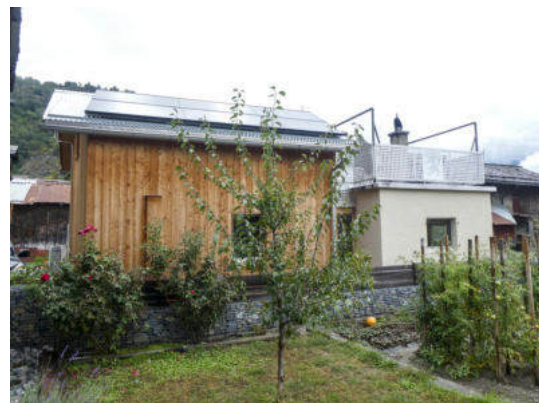
Nordwestansicht (© Castellani Architektur, Andreas Zimmerli, 09.2022)
