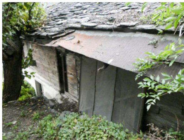
Ostseite, Zugänge Saal- und Wohngeschoss (© Castellani Architektur, Andreas Zimmerli, 10.2022)
