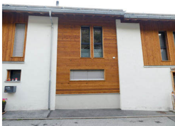
Nordseite, Zwischenbau (© Castellani Architektur, Andreas Zimmerli, 10.2022)
