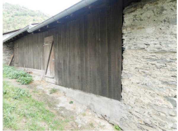
Nordwestansicht (© Castellani Architektur, Andreas Zimmerli, 09.2022)
