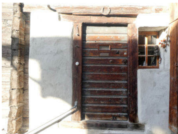
Ostseite, Zugang unteres Wohngeschoss (© Castellani Architektur, Andreas Zimmerli, 10.2022)
