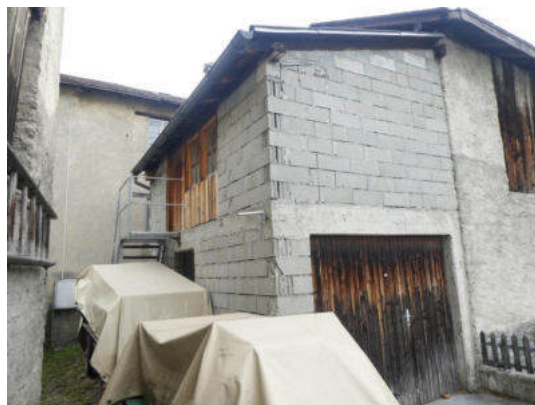
Nordwestansicht (© Castellani Architektur, Andreas Zimmerli, 10.2022)
