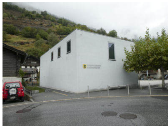
Südwestansicht (© Castellani Architektur, Andreas Zimmerli, 09.2022)
