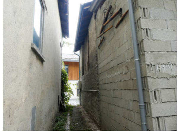
Ostseite, Zwischenraum zu Inv.-Nr. 39 (© Castellani Architektur, Andreas Zimmerli, 10.2022)
