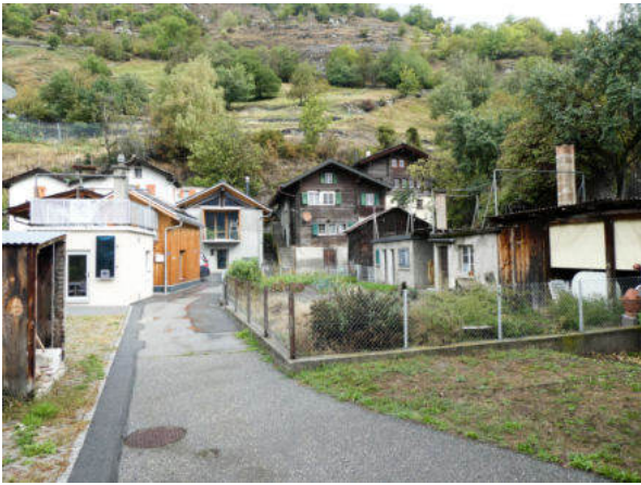
Südwestansicht Baugruppe und Nutzgärten (© Castellani Architektur, Andreas Zimmerli, 09.2022)
