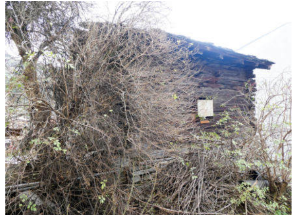
Nordwestansicht (© Castellani Architektur, Andreas Zimmerli, 12.2022)
