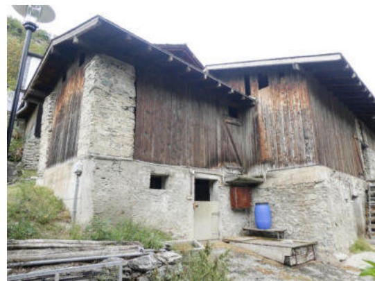
Südwestansicht (© Castellani Architektur, Andreas Zimmerli, 09.2022)
