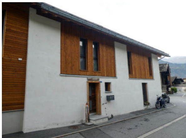
Nordseite, einstige Doppelstallscheune (© Castellani Architektur, Andreas Zimmerli, 10.2022)
