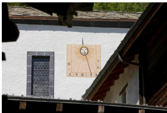
Sonnenuhr an der Südfassade (© DIB, KGS, Thomas Andenmatten, 2012).
