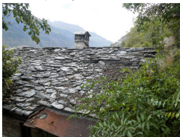
Ostseite, Dachfläche (© Castellani Architektur, Andreas Zimmerli, 10.2022)
