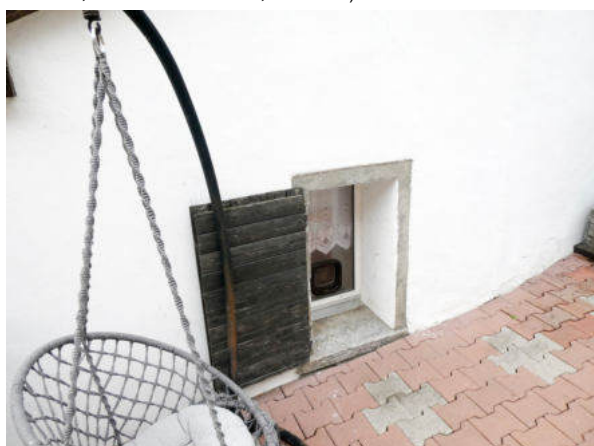
Nordseite, Fensteröffnung (© Castellani Architektur, Andreas Zimmerli, 10.2022)
