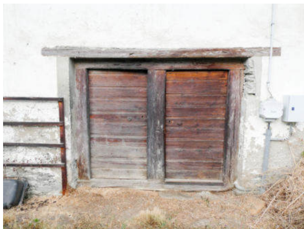
Südseite, Zwillingstüre Kellergeschoss (© Castellani Architektur, Andreas Zimmerli, 10.2022)
