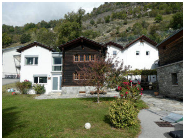
Südansicht Baugruppe (© Castellani Architektur, Andreas Zimmerli, 10.2022)
