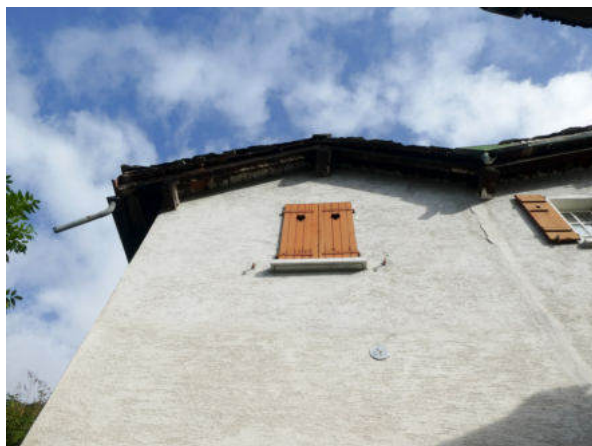
Südseite, zweite Erweiterung (© Castellani Architektur, Andreas Zimmerli, 10.2022)
