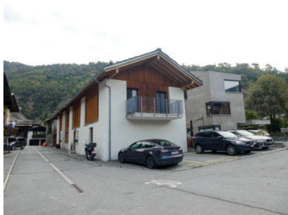
Nordwestansicht (© Castellani Architektur, Andreas Zimmerli, 10.2022)
