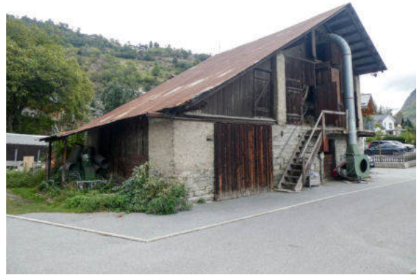
Nordwestansicht (© Castellani Architektur, Andreas Zimmerli, 09.2022)
