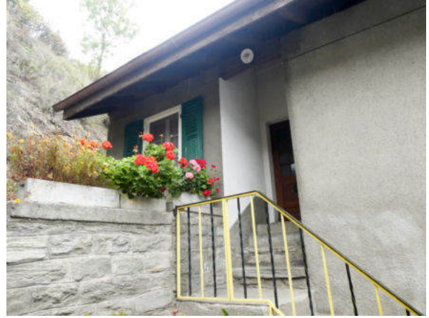
Westseite, Hinterhaus-Verlängerung (© Castellani Architektur, Andreas Zimmerli, 10.2022)
