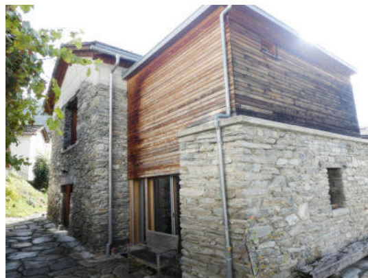
Nordwestansicht (© Castellani Architektur, Andreas Zimmerli, 10.2022)
