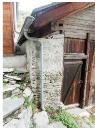
Nordwestansicht (© Castellani Architektur, Andreas Zimmerli, 09.2022)
