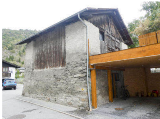
Nordwestansicht (© Castellani Architektur, Andreas Zimmerli, 09.2022)
