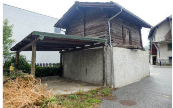
Nordwestansicht (© Castellani Architektur, Andreas Zimmerli, 09.2022)
