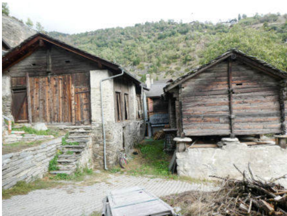
Westansicht Baugruppe (© Castellani Architektur, Andreas Zimmerli, 09.2022)
