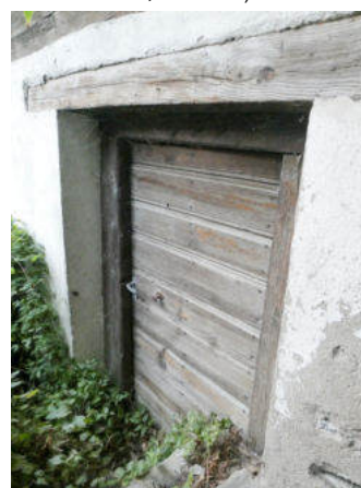
Ostseite, Zugang Schulstube im Saalgeschoss (© Castellani Architektur, Andreas Zimmerli, 10.2022)
