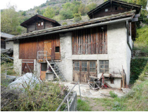
Südansicht Baugruppe (© Castellani Architektur, Andreas Zimmerli, 10.2022)
