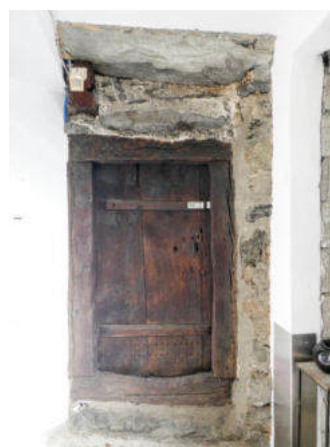
Ostseite, Türe Speicher unteres Wohngeschoss (© Castellani Architektur, Andreas Zimmerli, 10.2022)
