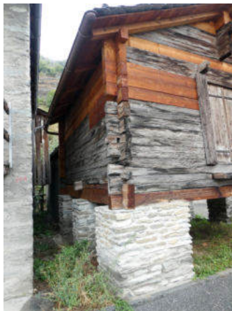
Südwestansicht (© Castellani Architektur, Andreas Zimmerli, 09.2022)
