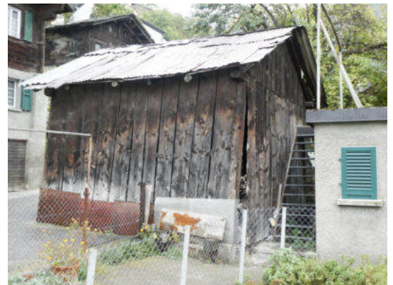
Südwestansicht (© Castellani Architektur, Andreas Zimmerli, 10.2022)
