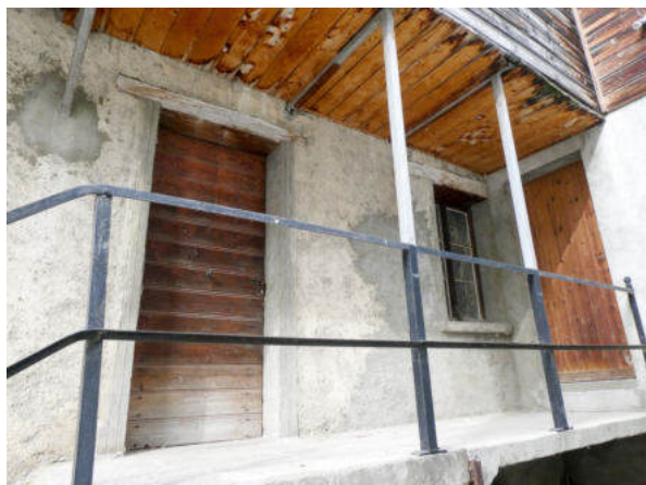
Ostseite, Zugang unteres Geschoss (© Castellani Architektur, Andreas Zimmerli, 10.2022)
