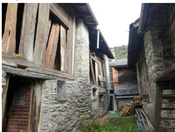
Südwestansicht (© Castellani Architektur, Andreas Zimmerli, 09.2022)
