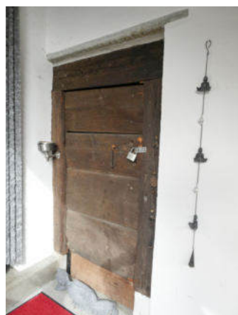
Ostseite, Türe Speicher oberes Wohngeschoss (© Castellani Architektur, Andreas Zimmerli, 10.2022)
