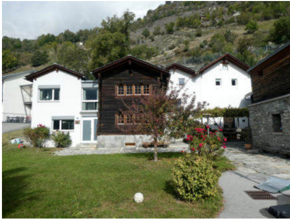
Südansicht Baugruppe (© Castellani Architektur, Andreas Zimmerli, 10.2022)
