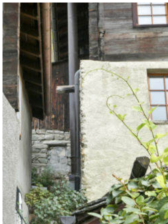
Ostseite, Abort-Anbau (© Castellani Architektur, Andreas Zimmerli, 10.2022)
