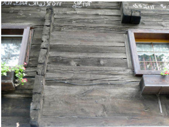
Südseite, Fassadenziegel oberes Wohngeschoss (© Castellani Architektur, Andreas Zimmerli, 10.2022)
