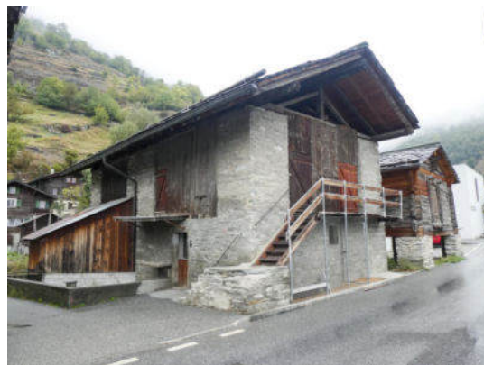
Südwestansicht (© Castellani Architektur, Andreas Zimmerli, 09.2022)
