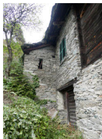
Westseite, Hinterhaus mit Abort-Anbau (© Castellani Architektur, Andreas Zimmerli, 10.2022)
