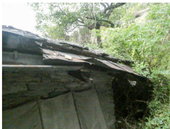
Ostseite, Anschluss Hinterhaus an Terrain (© Castellani Architektur, Andreas Zimmerli, 10.2022)
