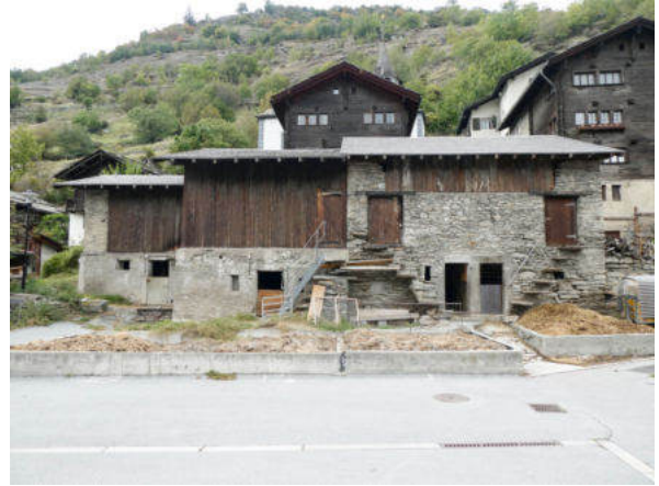
Südansicht Baugruppe (© Castellani Architektur, Andreas Zimmerli, 09.2022)
