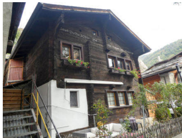
Südwestansicht (© Castellani Architektur, Andreas Zimmerli, 10.2022)
