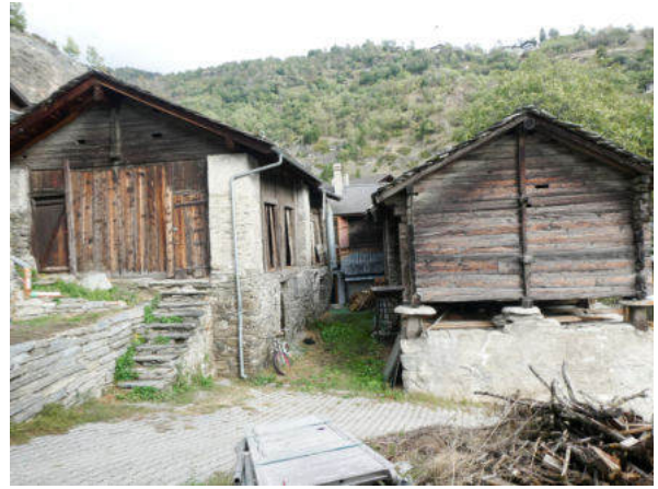
Westansicht Baugruppe (© Castellani Architektur, Andreas Zimmerli, 09.2022)
