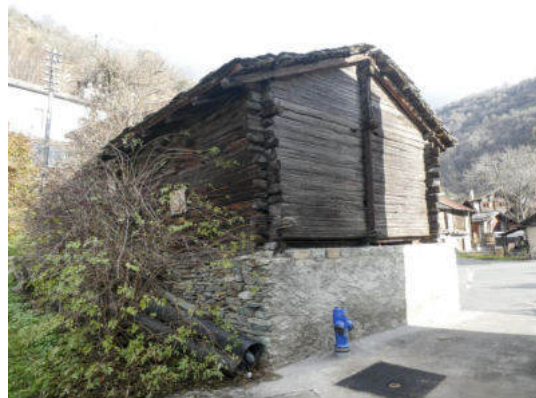
Südwestansicht (© Castellani Architektur, Andreas Zimmerli, 12.2022)
