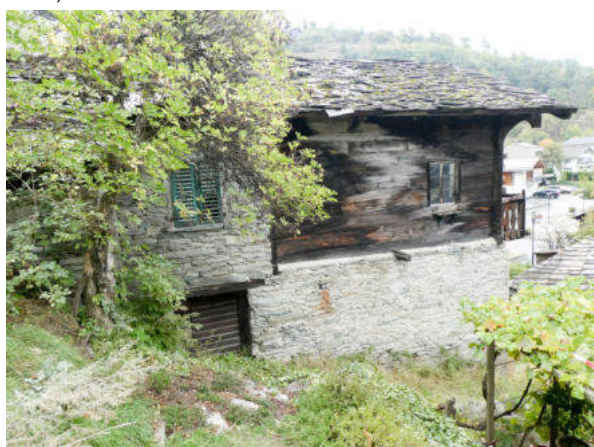
Nordwestansicht (© Castellani Architektur, Andreas Zimmerli, 10.2022)
