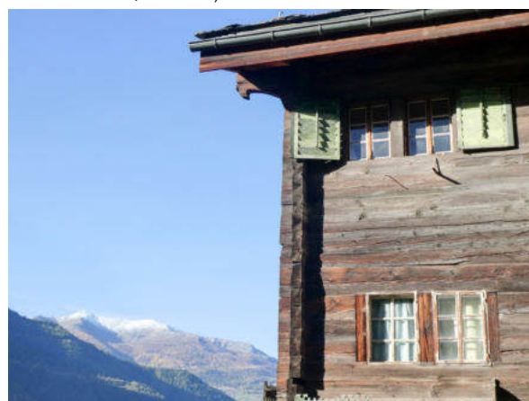
Südostecke, Oberbau mit Fensteröffnungen (© Castellani Architektur, Andreas Zimmerli, 10.2022)
