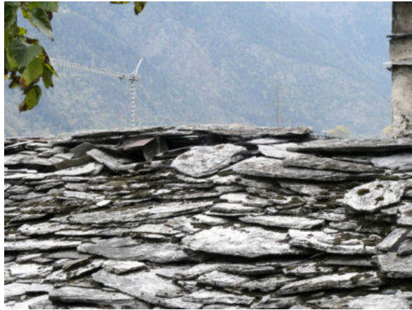
Ostseite, Dachfläche Firstbereich (© Castellani Architektur, Andreas Zimmerli, 10.2022)
