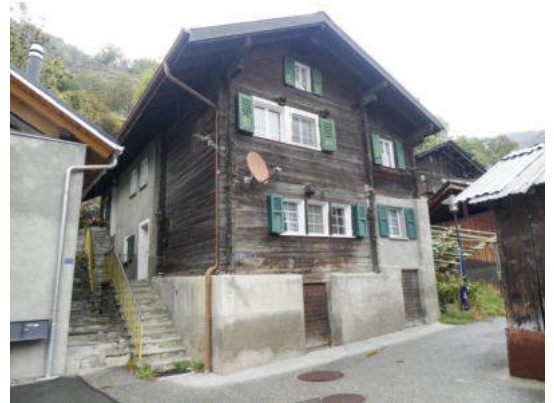
Südwestansicht (© Castellani Architektur, Andreas Zimmerli, 10.2022)
