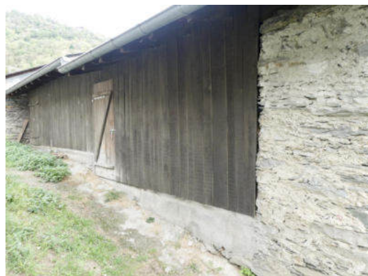
Nordwestansicht (© Castellani Architektur, Andreas Zimmerli, 09.2022)
