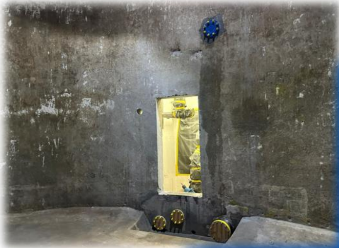
Sanierung Reservoir Schlecht «altes Becken»
