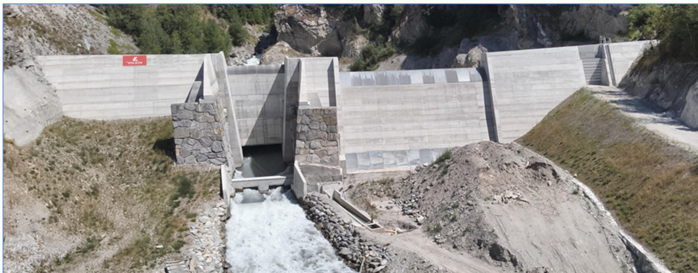
Abb. oben: Geschiebesperrenmauer mit Absetzbecken Wasserwasser und Fischzuchtwasser
