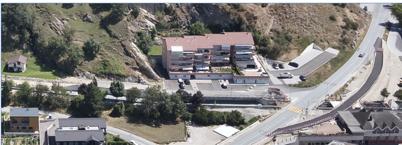
Abb. oben: Übersicht Bauarbeiten HWS Baltschiederbach mit Umgebungsarbeiten Panorama
